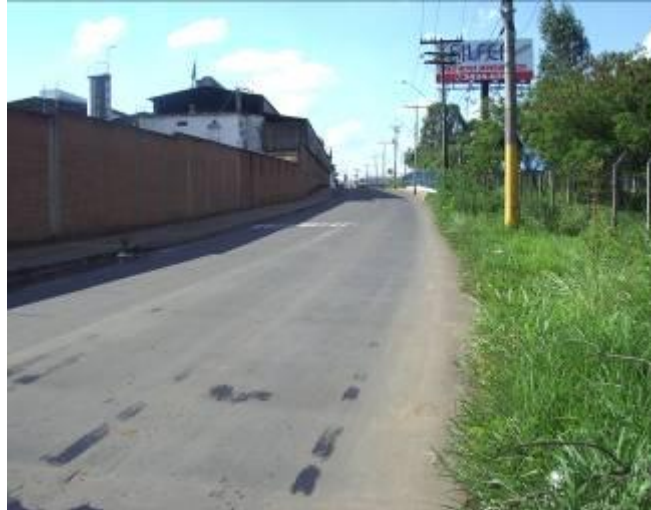
TRECHO EXPERIMENTAL DE PAVIMENTAÇÃO ASFÁLTICA COM AREIA DESCARTADA DE FUNDIÇÃO
