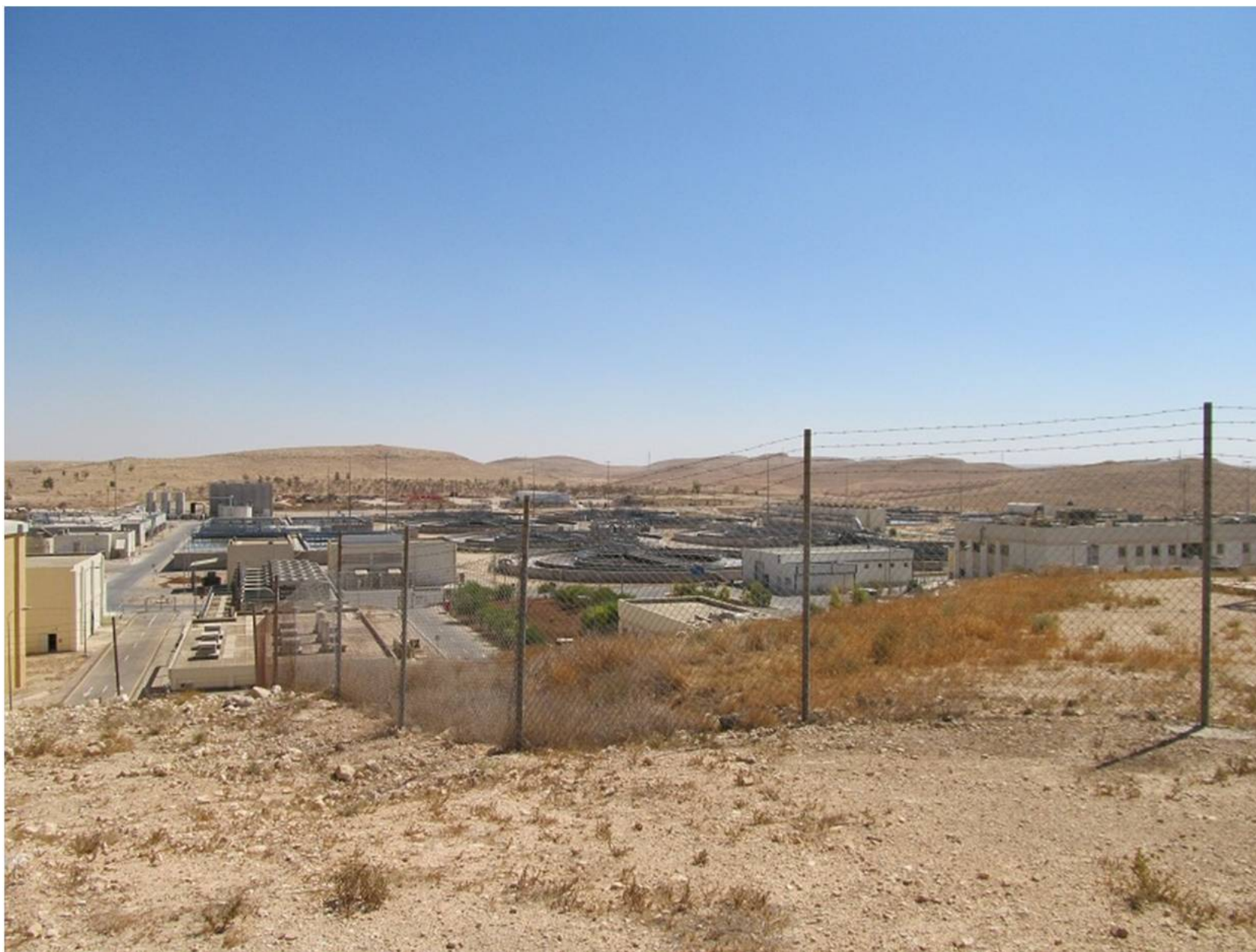
サムラ下水処理場(阪口直人衆議院議員ウェブサイトより)
