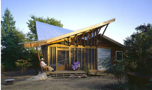
Fig. 4.1.11.- Butterfly House (1997), Samuel Mockbee. Fotografía exterior
