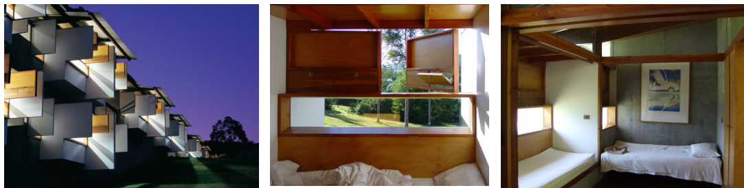
Fig. 4.1.17.- Residencia del Centro de Arte Boyd (1999), Glenn Murcutt, Riversdale, West Cambewarra, Australia. Fotografías interiores y exterior de las habitaciones de la residencia.
