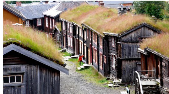
Fig. 4.1.19.- Fotografía de cubiertas vegetales en Røros, Noruega
