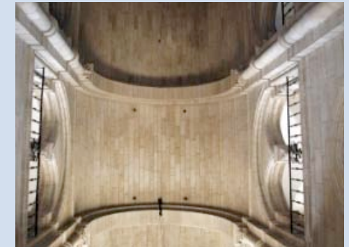
Bóveda de cañón con arcos fajones.
