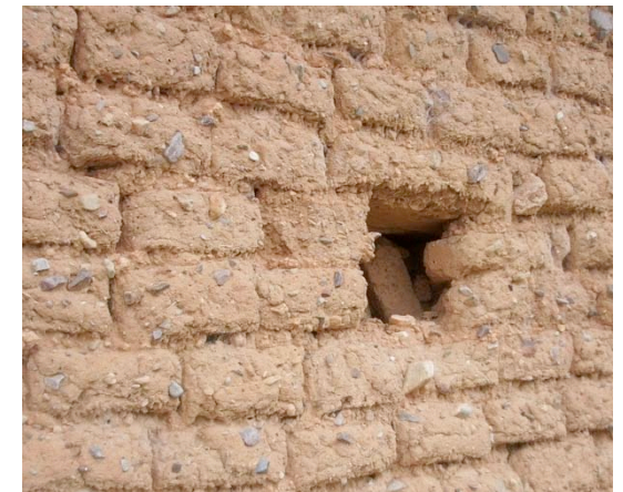
Muro de adobes.
