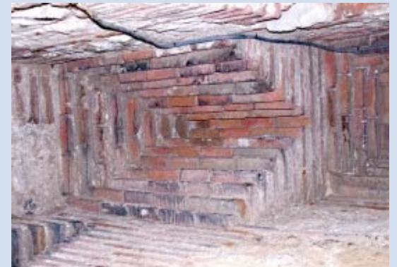
Bóveda por aproximación de hiladas.
