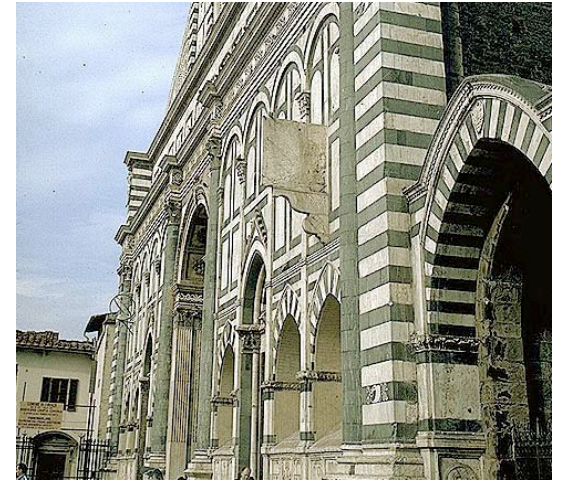
Muro chapeado. Fachada de la iglesia de Santa Maria Novella, Florencia.
