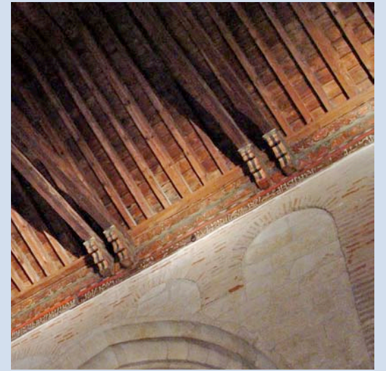
Canes bajo las tirantes de una armadura.
