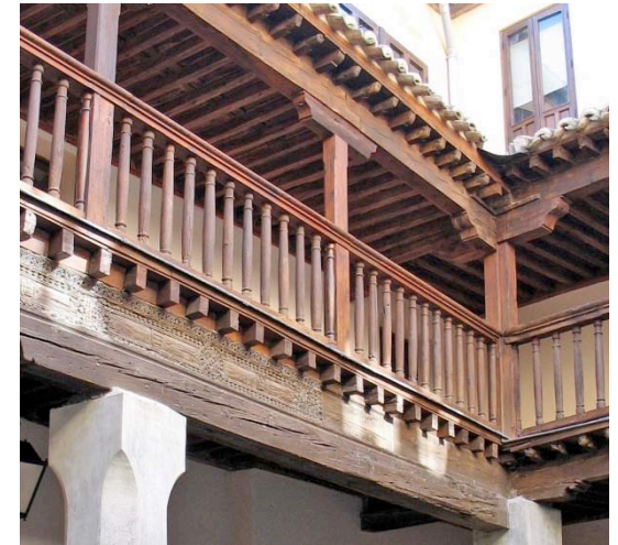
Pie derecho. Pies derechos de madera con zapatas*.
