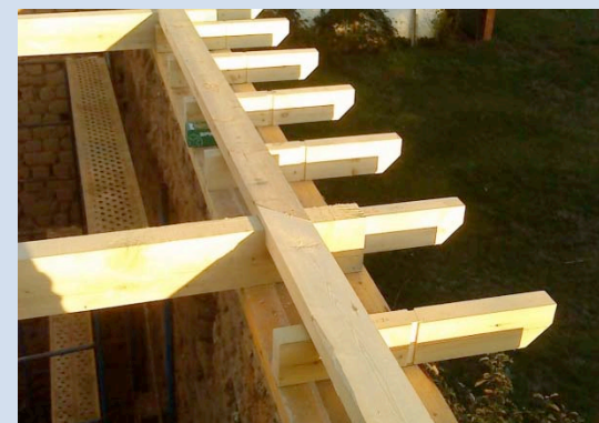
Estribo. Estribado de una armadura de cubierta.
