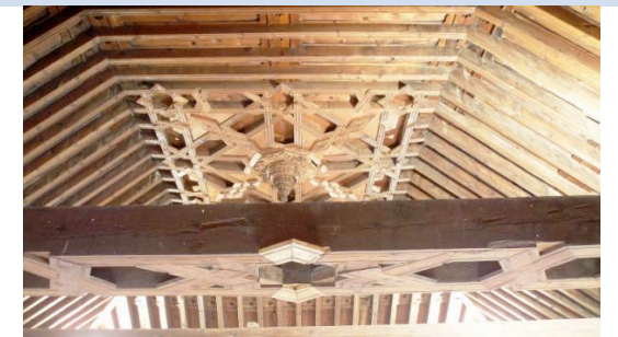
Par. Pares y nudillos en una armadura de cubierta.
