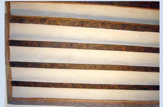
Bovedilla. Alfarje* con bovedilla de yeso.
