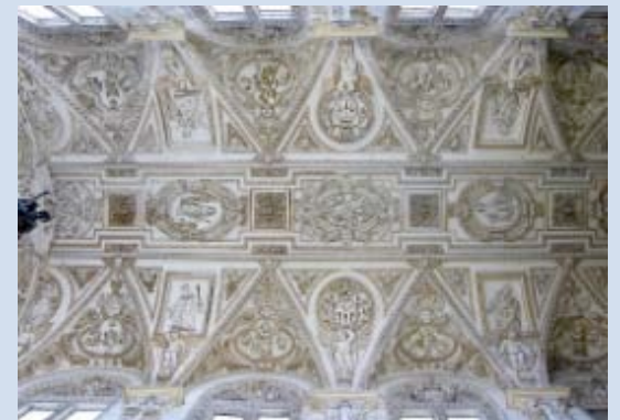
Bóveda de lunetos.
