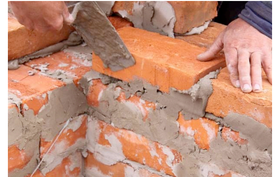
Junta. Rejuntado en fábrica* de ladrillo*.
