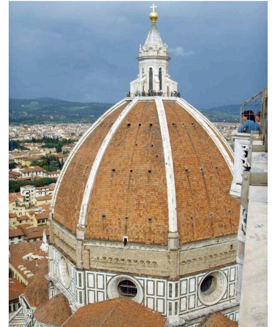
Bóveda de ladrillo.
