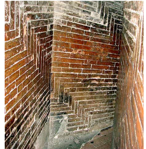
Bóveda de ladrillo. Aparejo de ladrillo a espinapez. F. Brunelleschi, cúpula de la catedral de Florencia.
