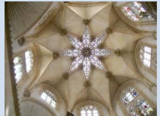
Bóveda estrellada de plementería calada.
