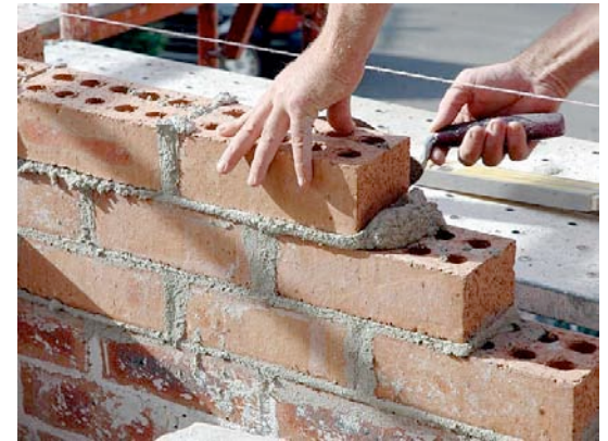
Llaga. Operación de rejuntado.
