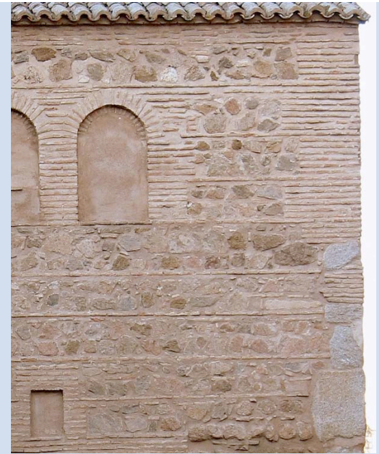
Verdugada. Muro de mampostería con verdugadas de ladrillo
