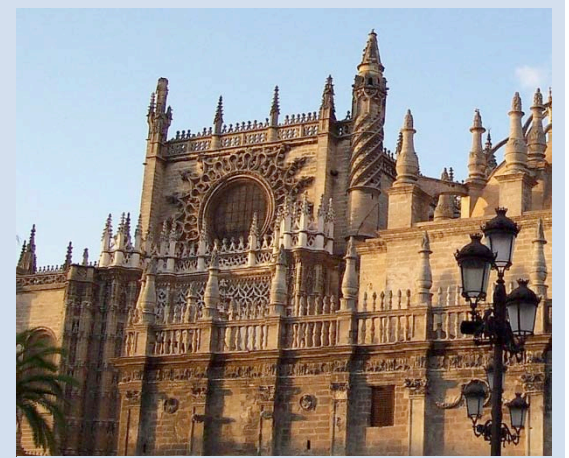
Cresterías. Catedral de Sevilla.
