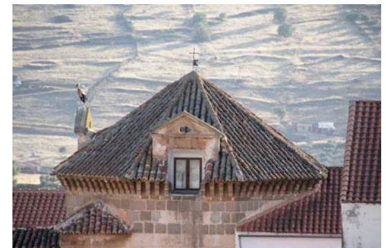
Cubierta en pabellón.
