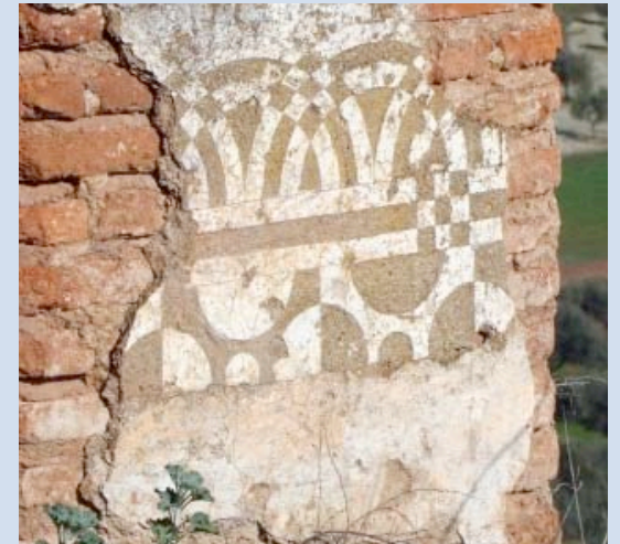
Esgrafiado sobre muro.
