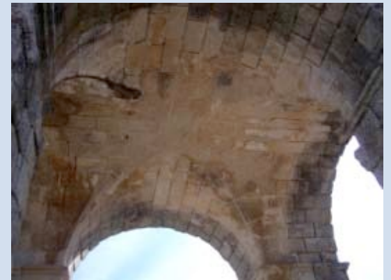
Bóveda de arista.
