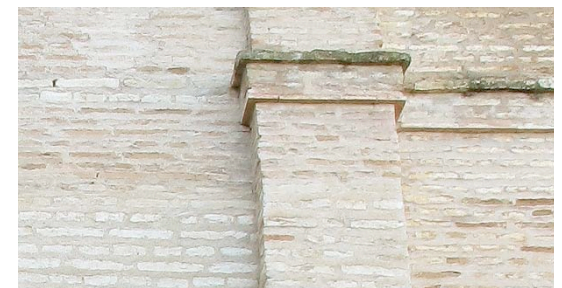
Ladrillo aparejado con gruesas llagas* y tendeles*.
