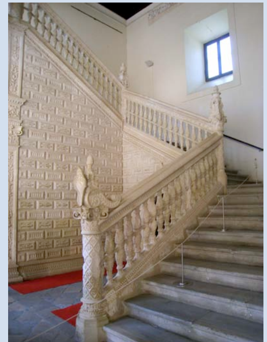
Muro. Muros de caja de escalera, A. Covarrubias, Hospital de Santa Cruz, s. XVI, Toledo.
