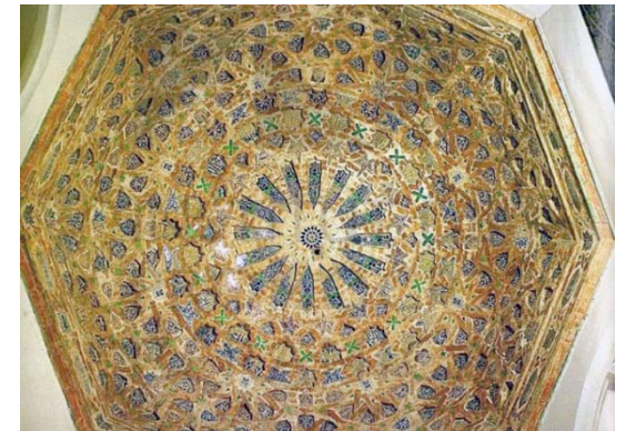
Bóveda alboaire. Capilla de San Jerónimo, Convento de la Concepción Francisca (Toledo).
