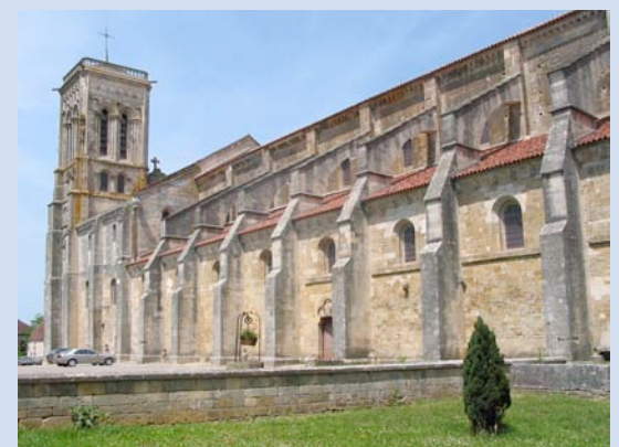
Estribo. Contrafuertes con arbotantes.
