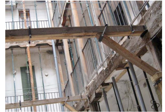
Apeos de un apuntalamiento.
