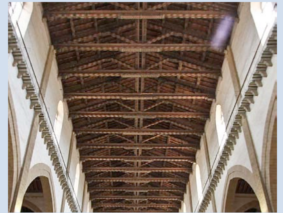
Tornapunta. Armadura de parhilera con tornapuntas o jabalcones. Iglesia de Santa Croce, Florencia.
