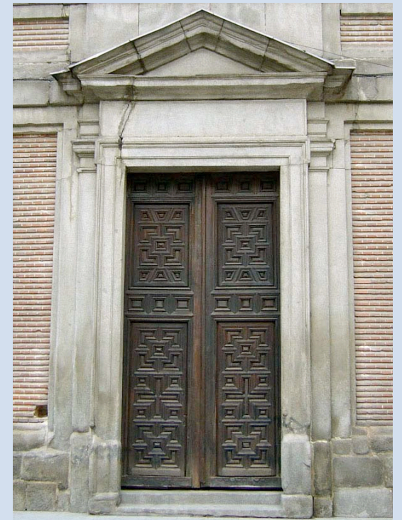
Vano. Vano adintelado. Monasterio de las Descalzas Reales, 1560-63, Madrid.
