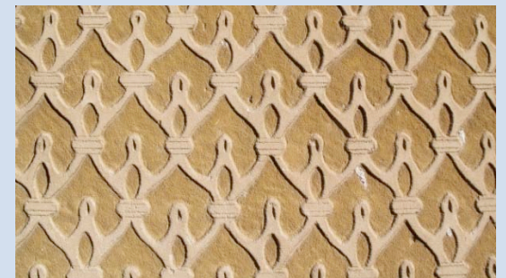
Esgrafiado sobre muro.
