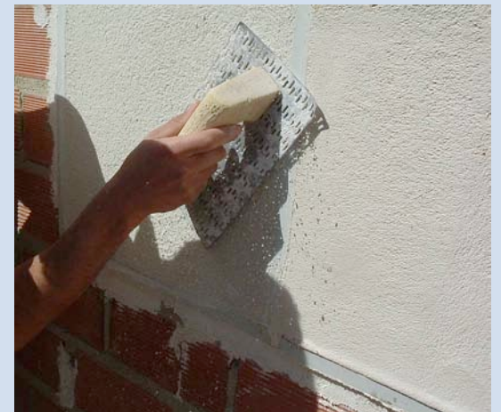
Tender. Tendido del enfoscado*.
