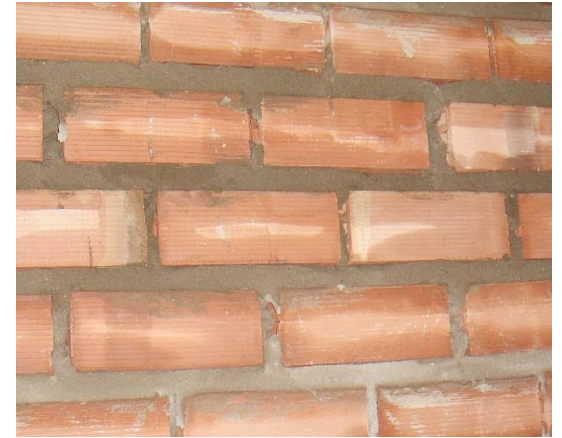
Tendel. Tendeles entre hiladas de ladrillo.
