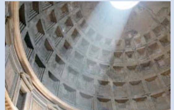
Bóveda alveolar. También, bóveda de casetones, o encasetonada, o artesonada.
