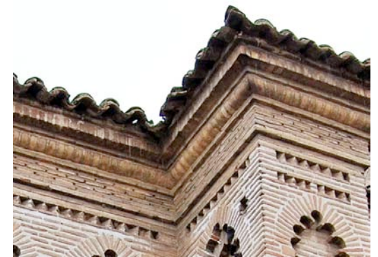
Sardinel. Ladrillos a sardinel soportando un alero*.
