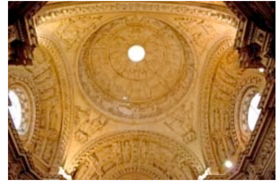
Cúpula de media naranja rebajada.
