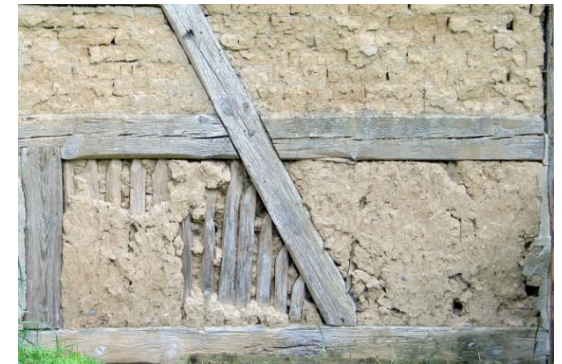
Muro de adobe con entramado de madera.
