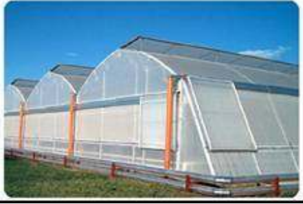
Figura 3. Invernadero en forma de Túnel
