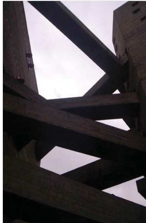
OBRA ARQ. LINA BOVARDI
