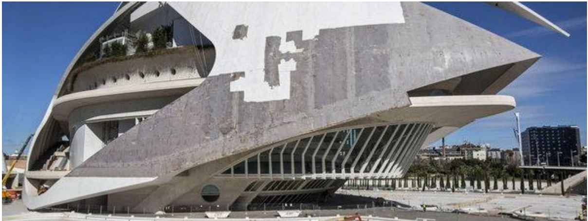
Retirada del revestimiento cerámico del Palau de les Arts Manuel Bruque
