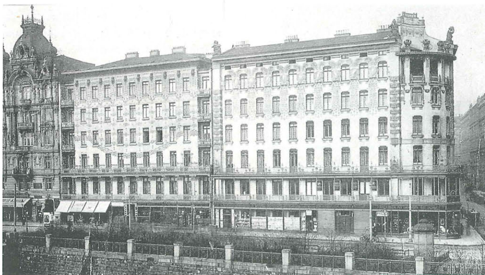
468. Otto Wagner, edificios de viviendas en Linke Wienzeile 38-40, Viena (1898-1899). El de la izquierda se conoce como la “Casa Mayólica” por el material cerámico del gran motivo ornamental que abarca toda la fachada.
