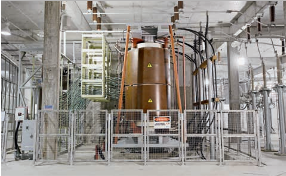
5a Con OLTC de tipo seco (izquierda)
