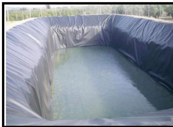
Figura 4. Utilización de geomembranas HDPE y LLDPE en el reservorio de agua potable. Tomado de: http://criarpeces.com.ar/wp-content/uploads/2014/03/Informaci%C3%B3n-de-las-geomembranas.pdf
