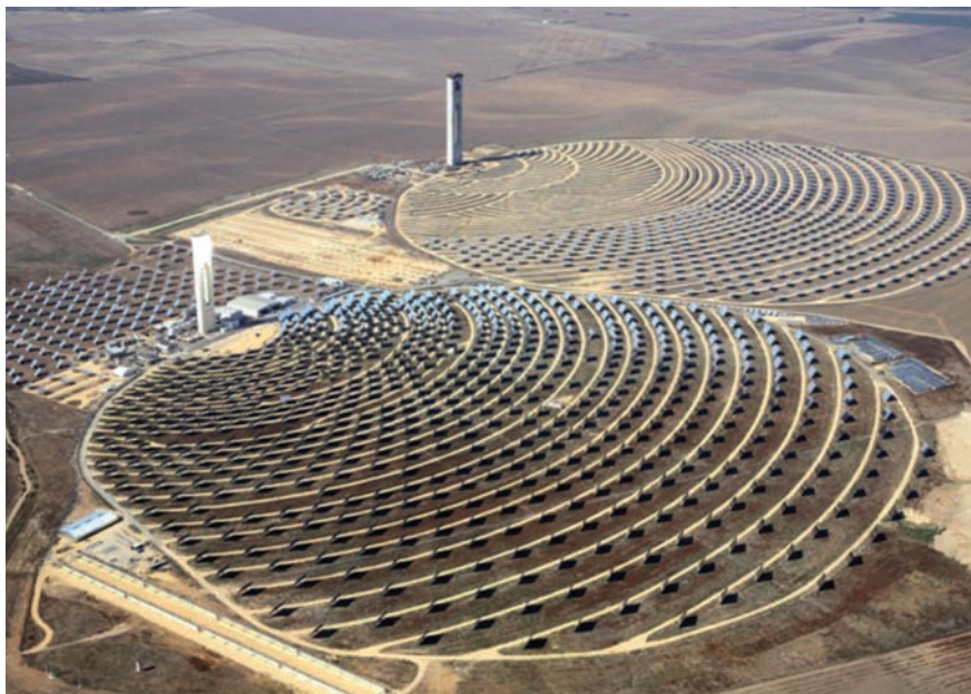
Figura 3. Planta solar de torre central PS-10 en operación (frente) y planta PS-20 en construcción (al fondo). Fotografía: Abengoa Solar.
