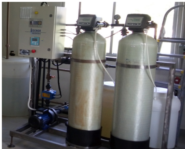
Figura 1. Sistema Deionizador. Fonte: autor (2017).
