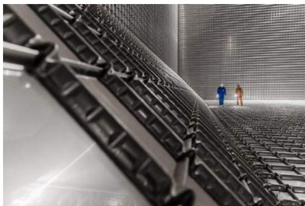
13 - Tanque de membrana (GTT).
