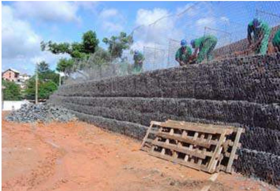
Figura 11: aplicação de um muro de solo reforçado *Terramesh® System* (MACCAFERRI AMÉRICA LATINA, 2009a)
