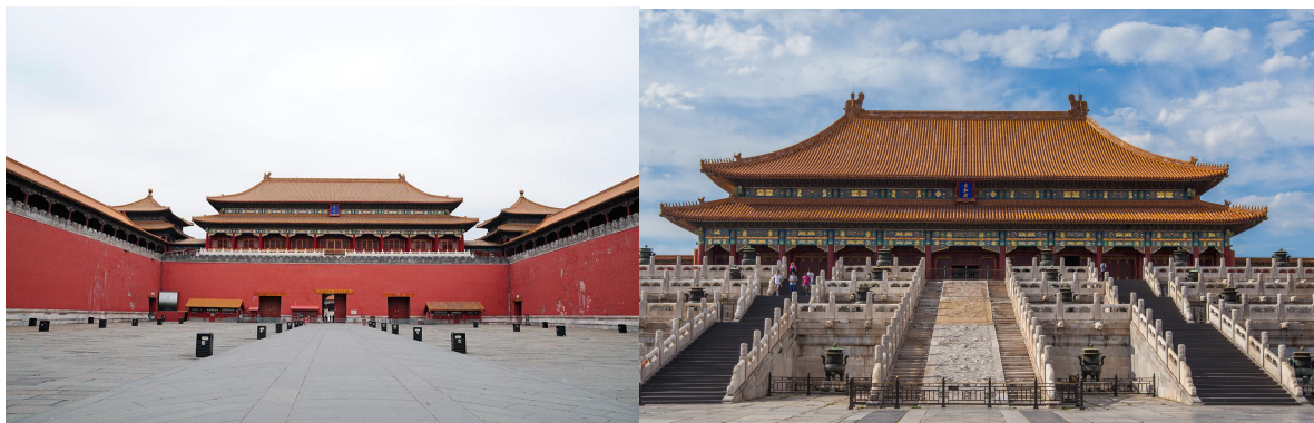
Figura 52, 53. Fotos del Palacio Imperial. (Fotografía realizada por el autor)
