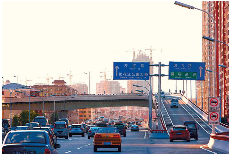
Figura 133. “Sha” de puente. ( http://soso.nipic.com/?q=桥 )
