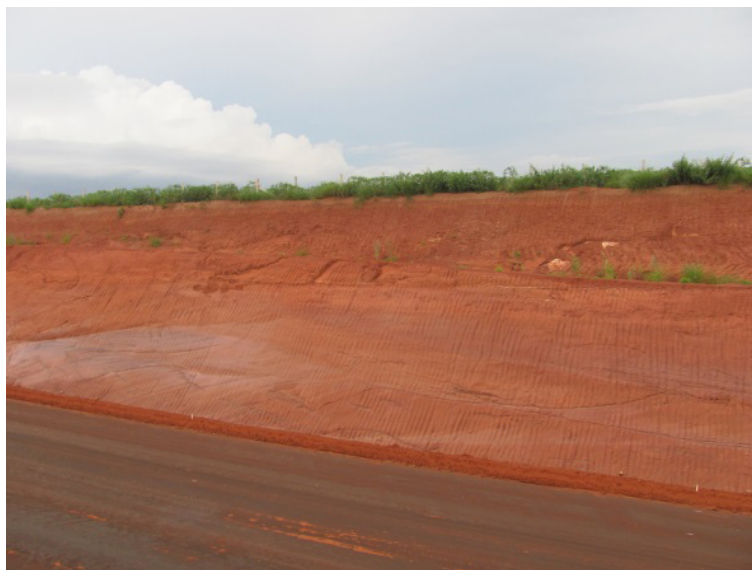
FIGURA 1 - CORTE DE ESTRADA COM PERFIL DE SOLOS ARENOSOS NO NOROESTE DO PARANÁ.
