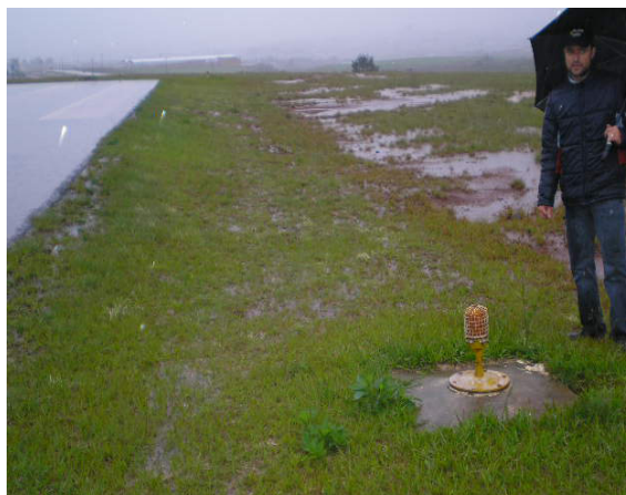
FIGURA 5 – FLUXO SUPERFICIAL DIFUSO EM CABECEIRA DE PISTA DO AEROPORTO DE GUARAPUAVA
