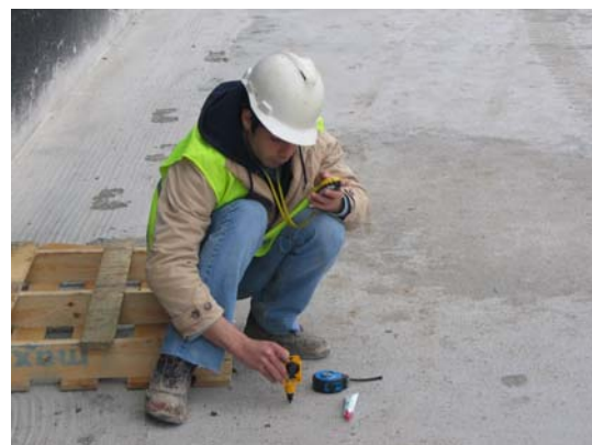
Figura 37: Fórum Coimbra – Marcação dos pontos do lancil
