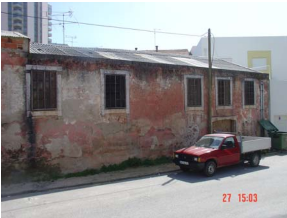
Figura 34: Auto Industrial - Fachada posterior
