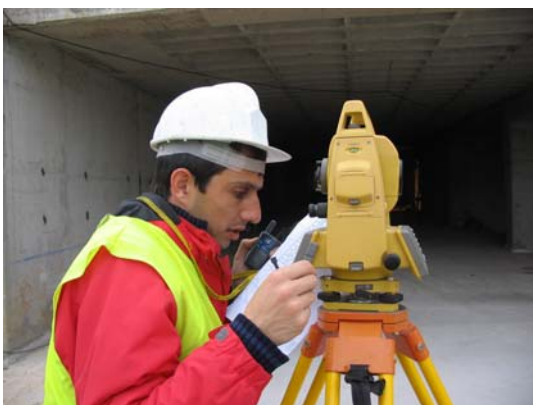
Figura 37: Fórum Coimbra – Marcação dos pontos do lancil
