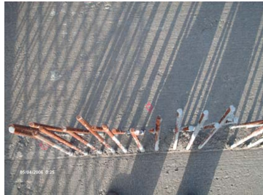
Figura 39: Condomínio Zen – Marcação dos eixos
