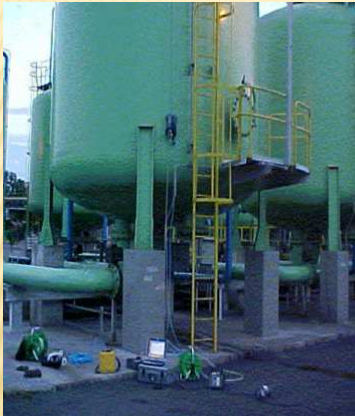
Robô inspeção de tanques
