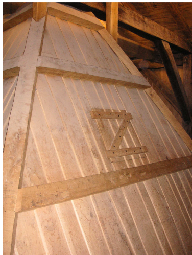
Foto sacada desde el pajar de Landetxo Goikoa en la que se ve desde fuera, la chimenea de la cocina
