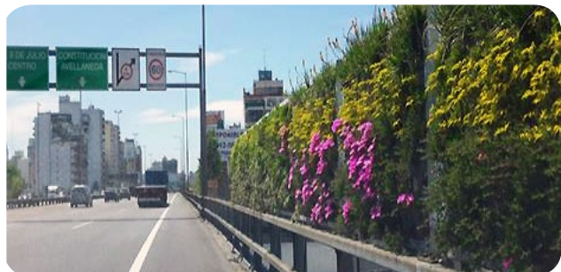
Muros verdes en los límites de la autopista mitigan los ruidos.
