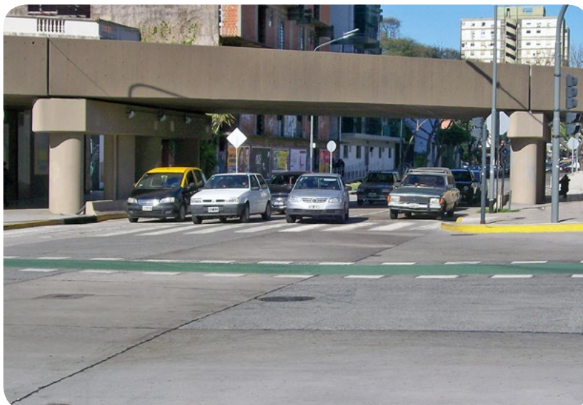
Pavimento de hormigón de uso vehicular.
