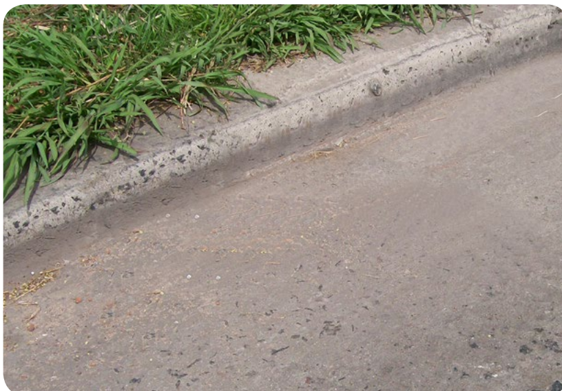
Detalle de cordón cuneta de hormigón.
