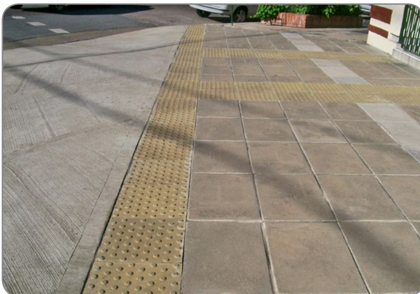
Señalización de esquina
