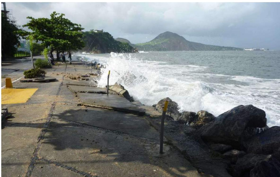
**Figura 29.14.** Exemplo de galgamento das ondas (*overtopping*) em muro de enrocamento com destruição de benfeitorias durante evento de ondas de tempestade em abril de 2010. Baía de Guanabara, Niterói, RJ.
