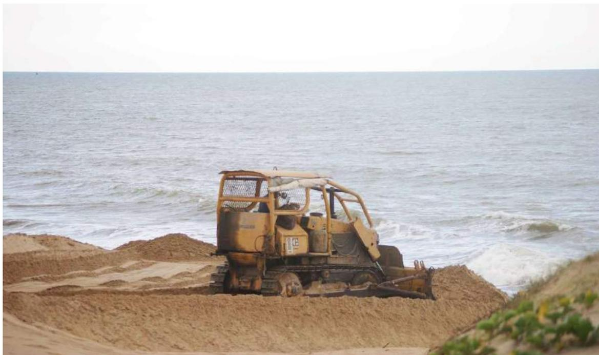
**Figura 29.20.** Remobilização mecânica das dunas frontais em Atafona, São João da Barra, RJ. Tal procedimento foi definido para interromper o avanço das dunas frontais sobre ruas, avenidas e residências. Optou-se por mecanicamente "empurrar" as dunas em direção ao mar e em seguida realizou-se o plantio de vegetação fixadora. Tais procedimentos foram eficientes por um curto intervalo de tempo.
