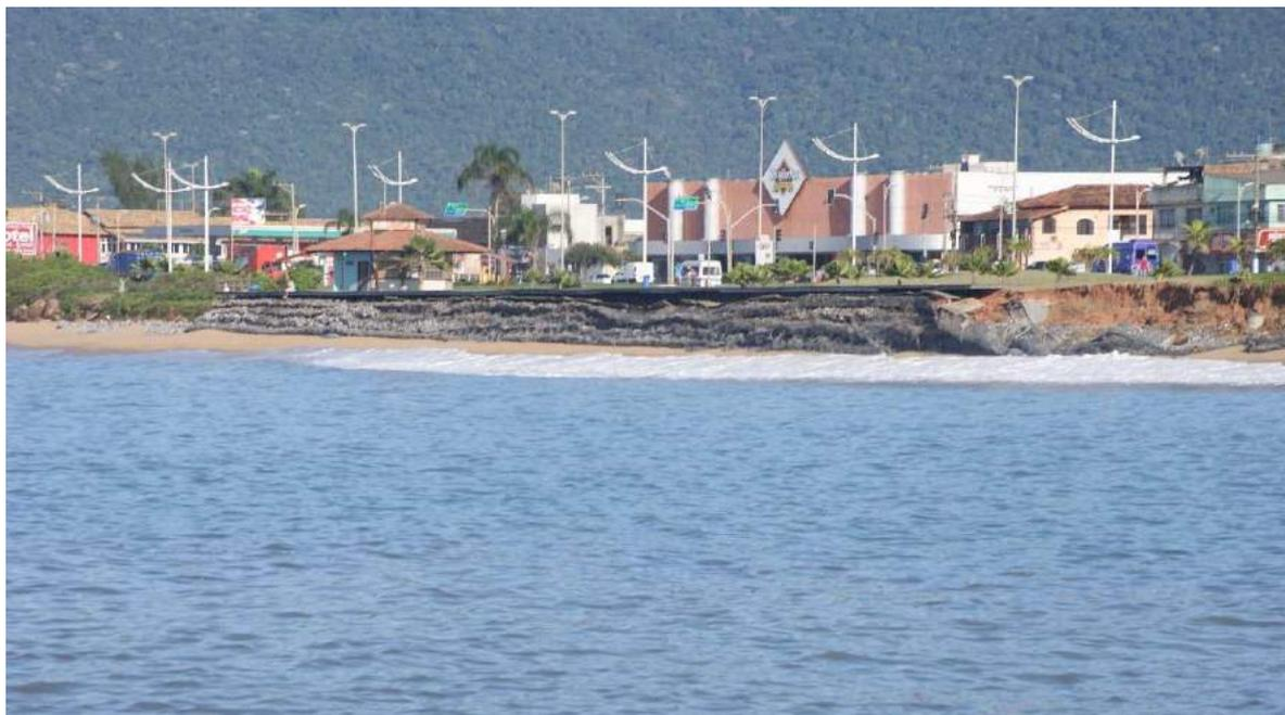
**Figura 29.13.** Exemplo de colapso de estrutura do tipo muro de gabião na praia da Tartaruga, Rio das Ostras, RJ.
