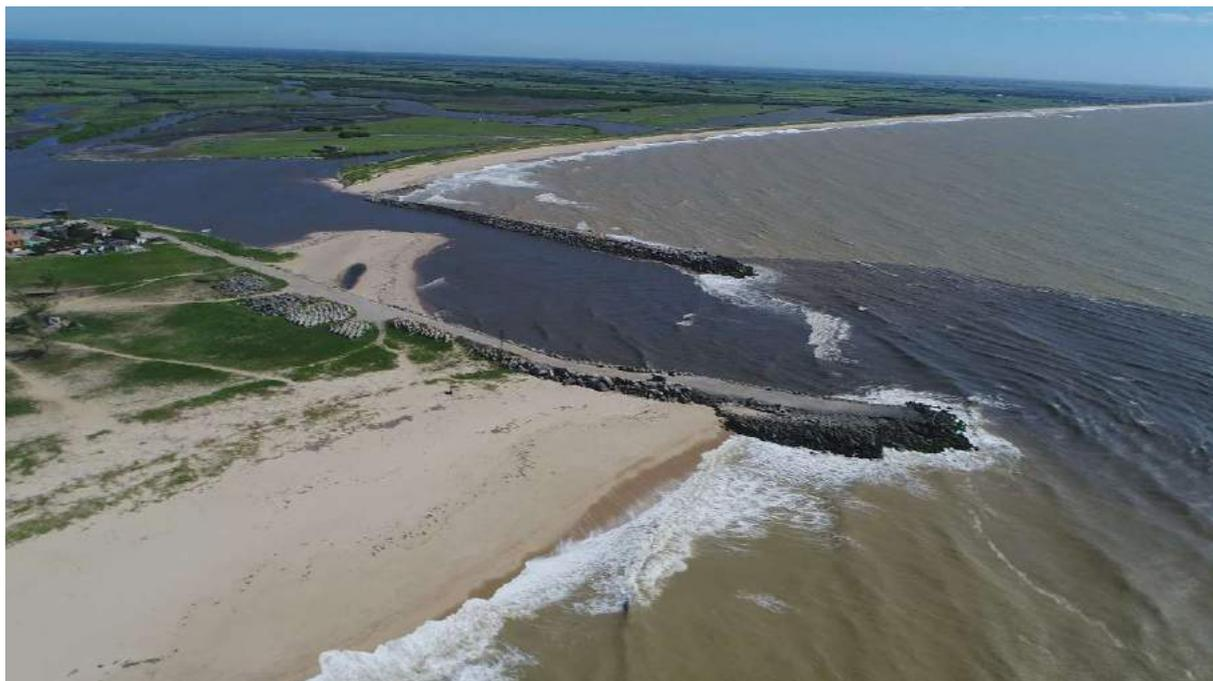
**Figura 29.1.** Assimetria na posição da linha de costa em resposta à construção de estruturas perpendiculares (espigões guia-corrente) em litoral com transporte de sedimentos de rumo dominante sul-norte. Barra do Furado, Quissamã, RJ. Tal assimetria chegou a 290 metros em 30 anos (Ribeiro et al., 2016) com taxas de acumulação ao sul semelhantes às taxas de erosão ao norte.
