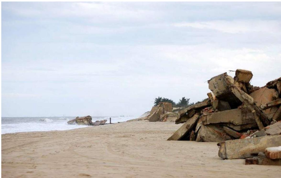
**Figura 29.19.** Praia de Atafona, São João da Barra, RJ. Cinco décadas de erosão costeira e de estratégia de "fazer nada" resultaram na perda aproximada de 1.000.000 m<sup>2</sup> e mais de 180 residências, ao longo de 14 quarteirões. Para uma revisão sobre o tema ver Bulhões (2018b).
