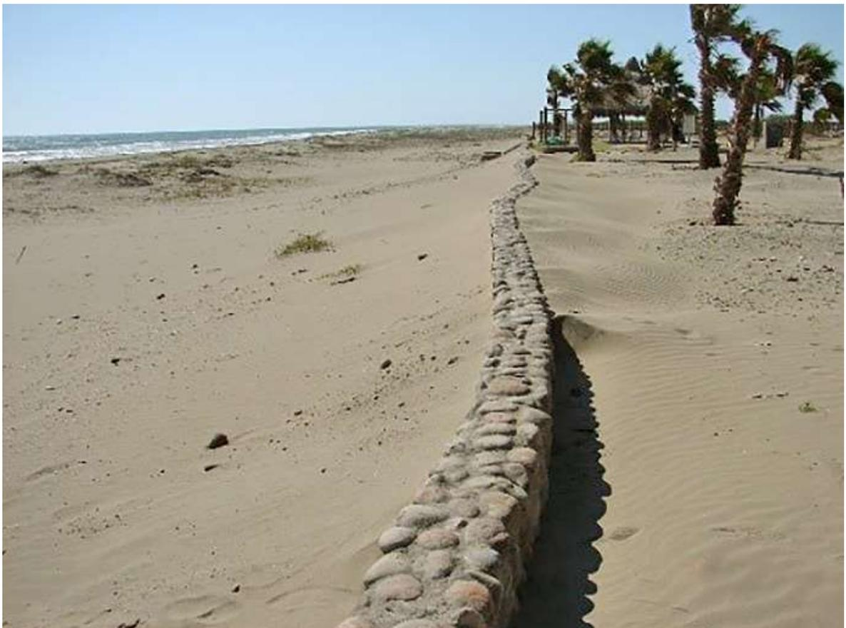
**Figura 2.1.** Dunas frontais defronte à retropraia com muro de contenção. Novo Altata, Sinaloa, México.
