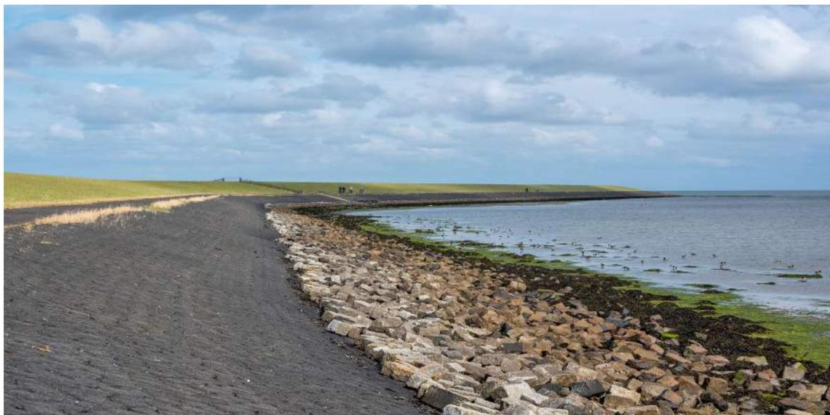
**Figura 29.15.** Dique coberto por grama, concreto e protegido por enrocamento na Holanda.
