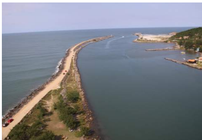
Fig. 2.82 - Conexão do Canal dos Molhes da Barra com o oceano (Laguna- SC).
