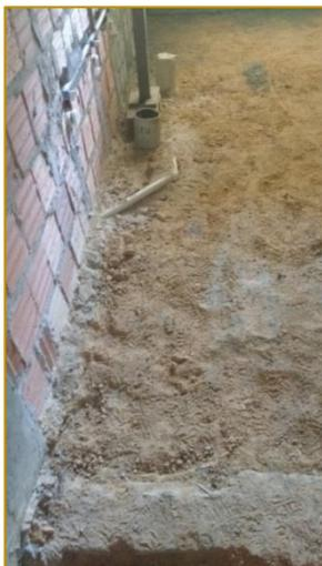
Figura 7. Rebaixamento das instalações hidráulicas.
