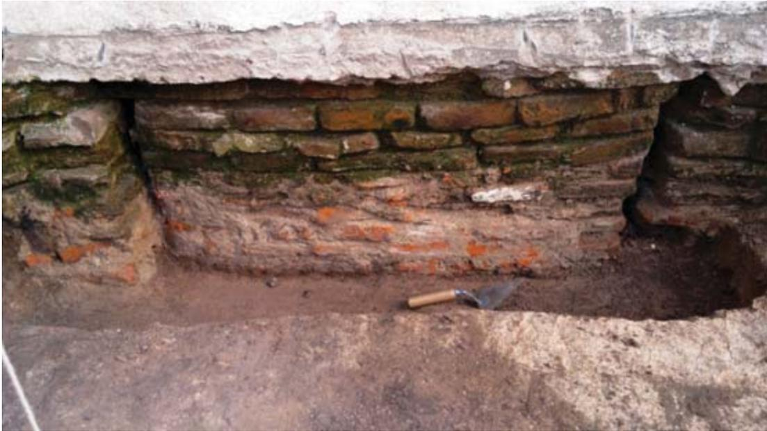
Sector diferenciado en un cimiento identificado gracias a la limpieza de los ladrillos y sus juntas. Debe corresponder a una estructura anterior, luego ampliada (Venezuela 469).
