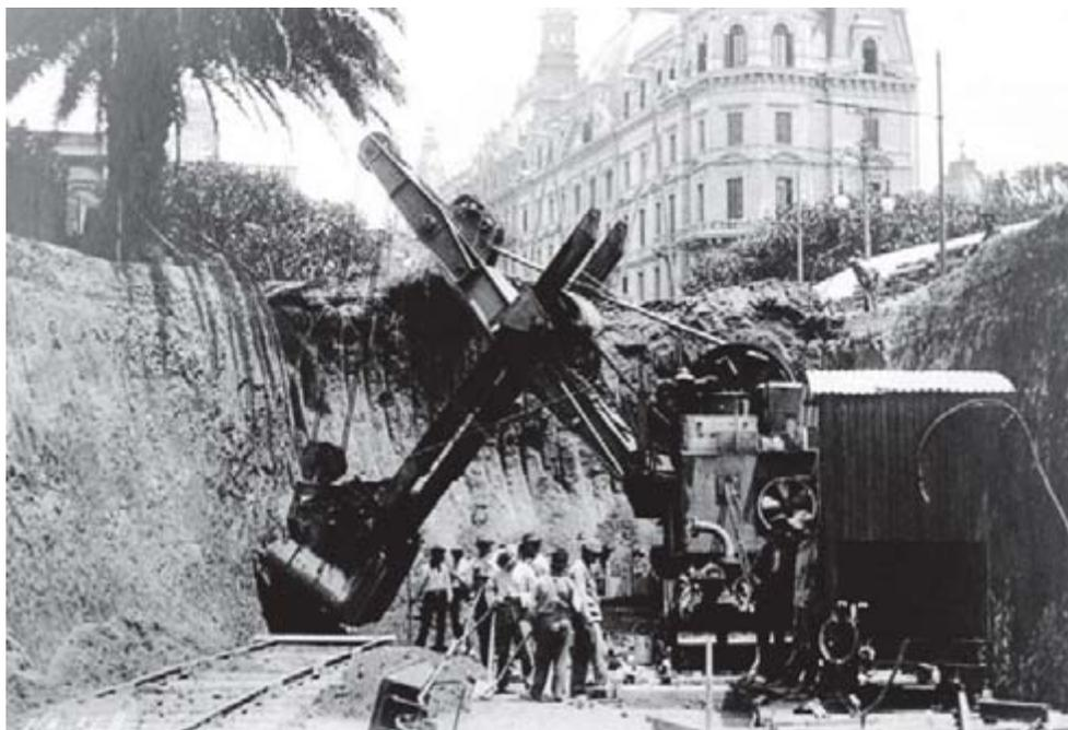
Excavación del subterráneo en Plaza de Mayo a cielo abierto, nótese la envergadura de las obras para la línea A en 1912. Tras construir el túnel la zanja fue rellenada, pero la tierra retirada se llevaba y se trajo nueva desde otro sitio.
