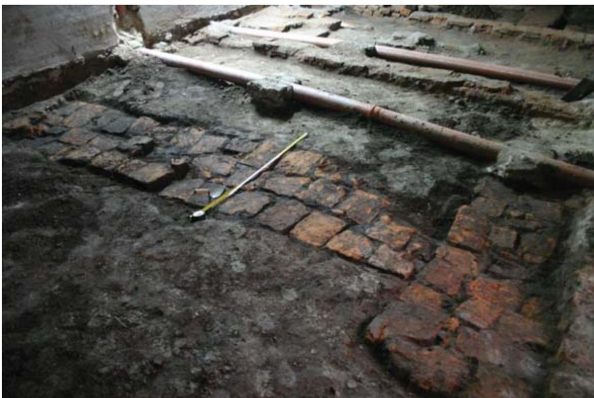
Cimientos de una vivienda del siglo XVII (Bolívar 375) encontrados al levantarse el piso de ca. 1885 remodelado en 1935; nótese que están hechos de medios ladrillos, a pocos centímetros del piso moderno.
