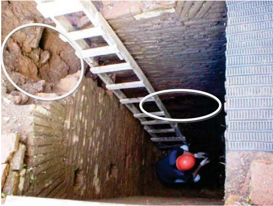
Pozo de descarte: nótese los sectores derrumbados y la incómoda escalera; bordes de apoyo cubiertos de goma para evitar roturas (Casa Alfaro, San Isidro).
