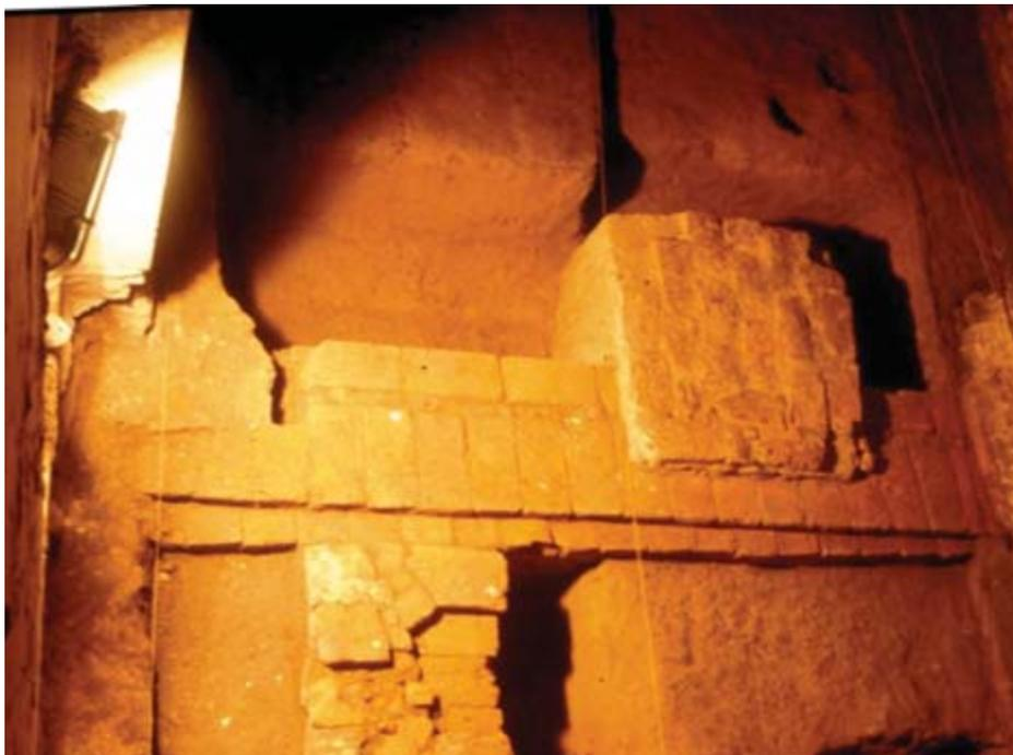
Base de una columna vista en un piso roto. Limpia y sin el piso se ve que se apoya sobre un cimiento anterior de ladrillos enteros, unido a otro de fragmentos y diferente factura (Perú 680).
