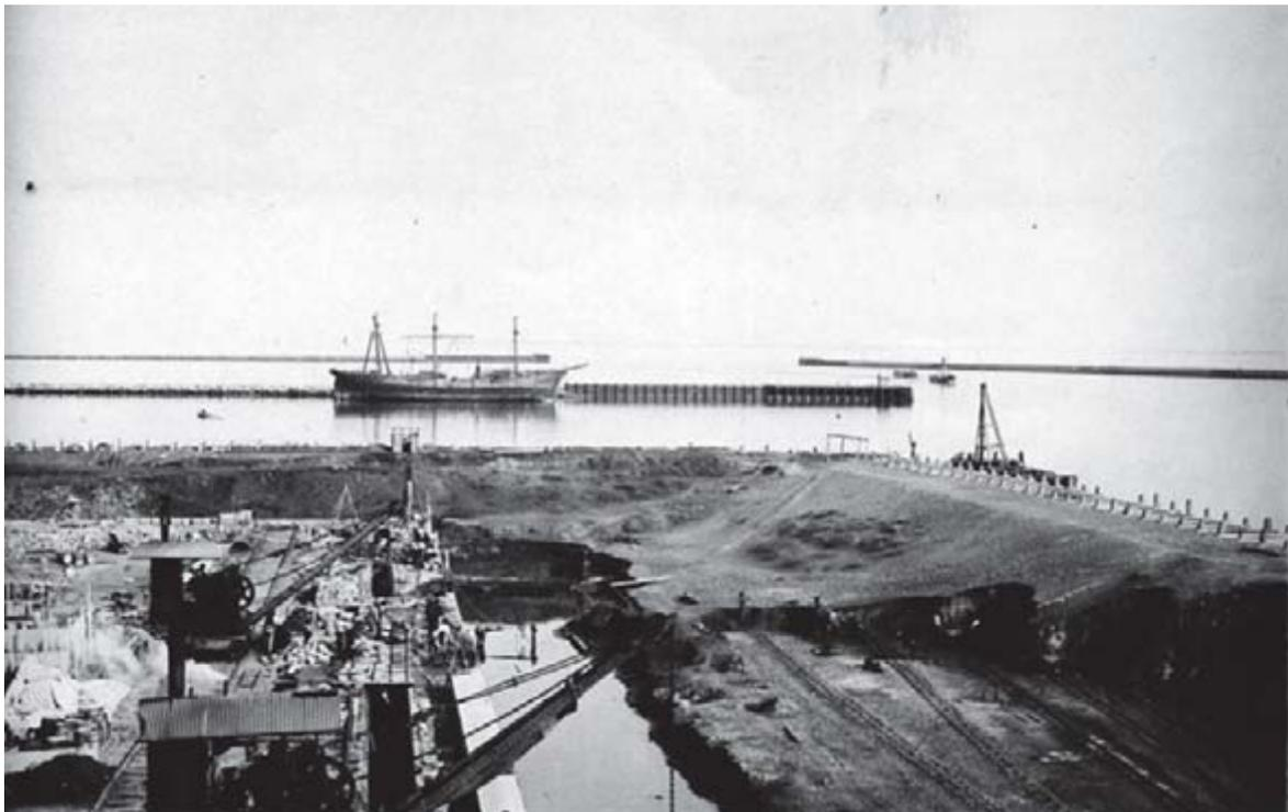
Dársena Norte, proceso de relleno con sedimento del río sacado con dragas, se lo colocaba formando estratos de afuera hacia adentro acarreado por las grúas.
