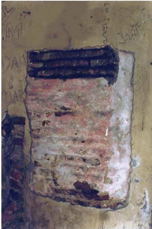
Muro de ladrillos fechado hacia 1790 con varias capas de blanqueo, la primera era rojiza; encima tiene un revoque moderno de cemento pintado de amarillo. Las juntas visibles son de barro (San Juan 338).
