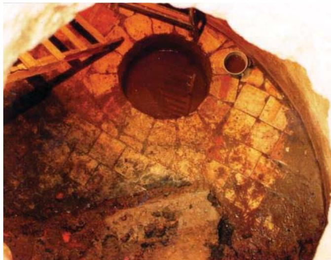
Pozo de decantación en el piso de una cisterna de aljibe de la calle Defensa 755, colocado excéntrica pese a ser una estructura circular.
