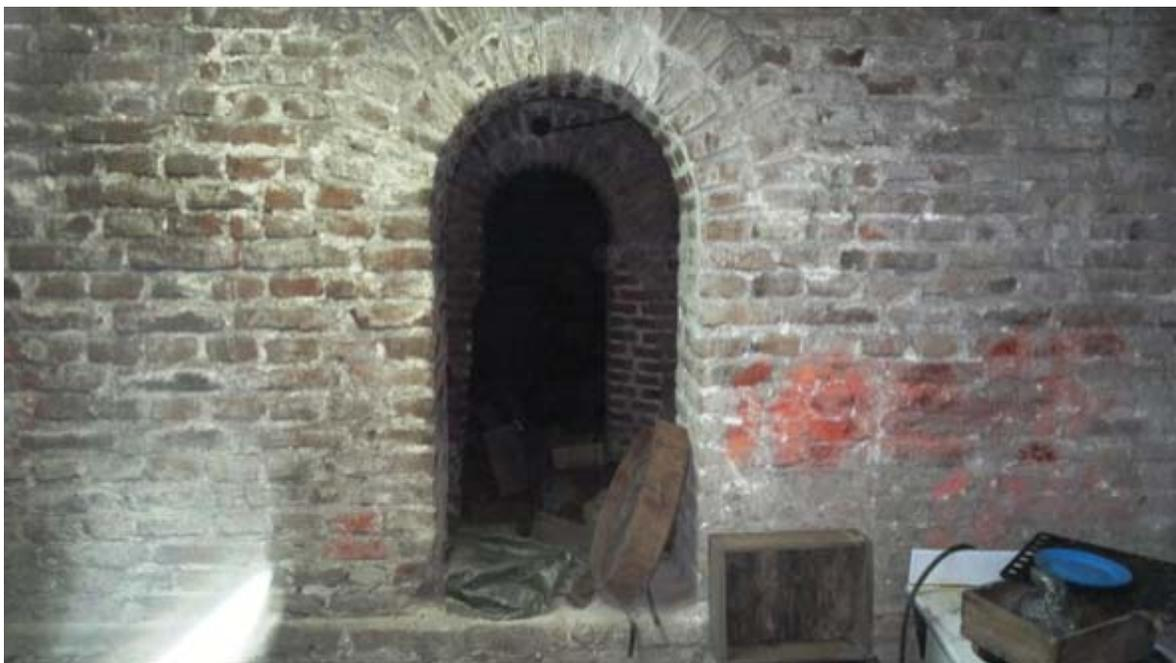
Entrada a las galerías y sótanos bajo el Hospital Borda (Pabellón Jones), resultado de un sistema constructivo que dejó los cimientos expuestos para ser usados con funciones de servicios.
