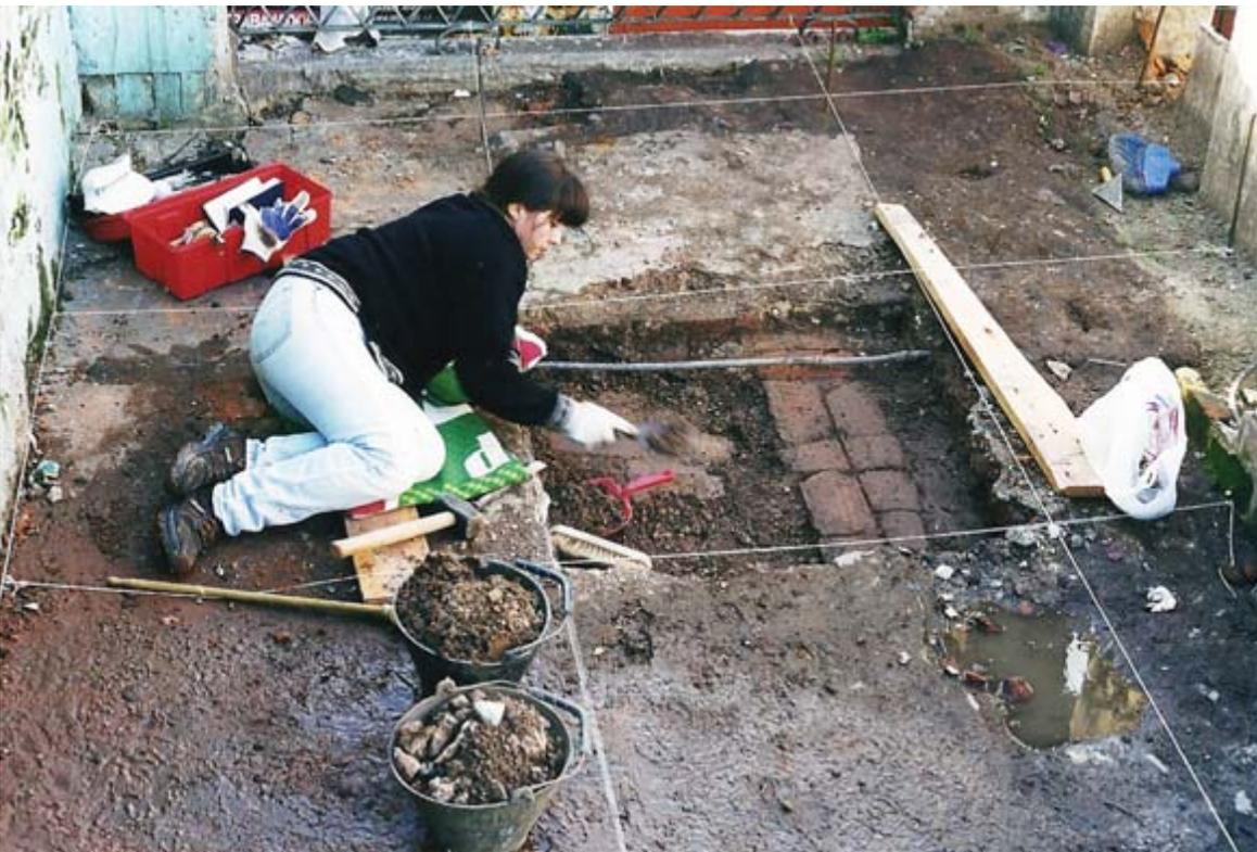
Inicio de la excavación: aparece una hilada de ladrillos sin revocar de un cimiento y el enladrillado a un lado. Las condiciones siempre son sucias, es una obra en proceso (San Juan 338).
