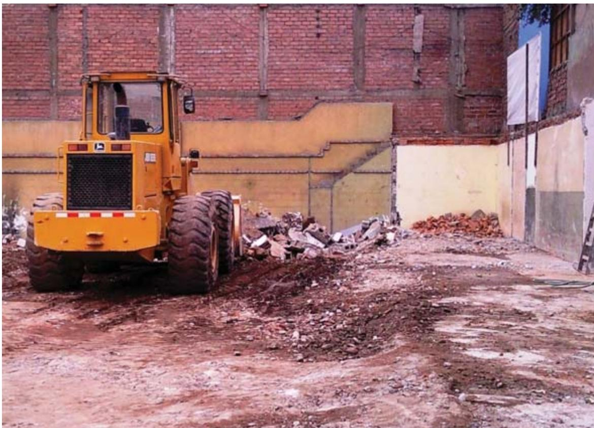
Demolición en proceso de retiro del escombro: nótese en la medianera del fondo los pisos superpuestos y las diversas escaleras de ladrillos de diferentes épocas.
