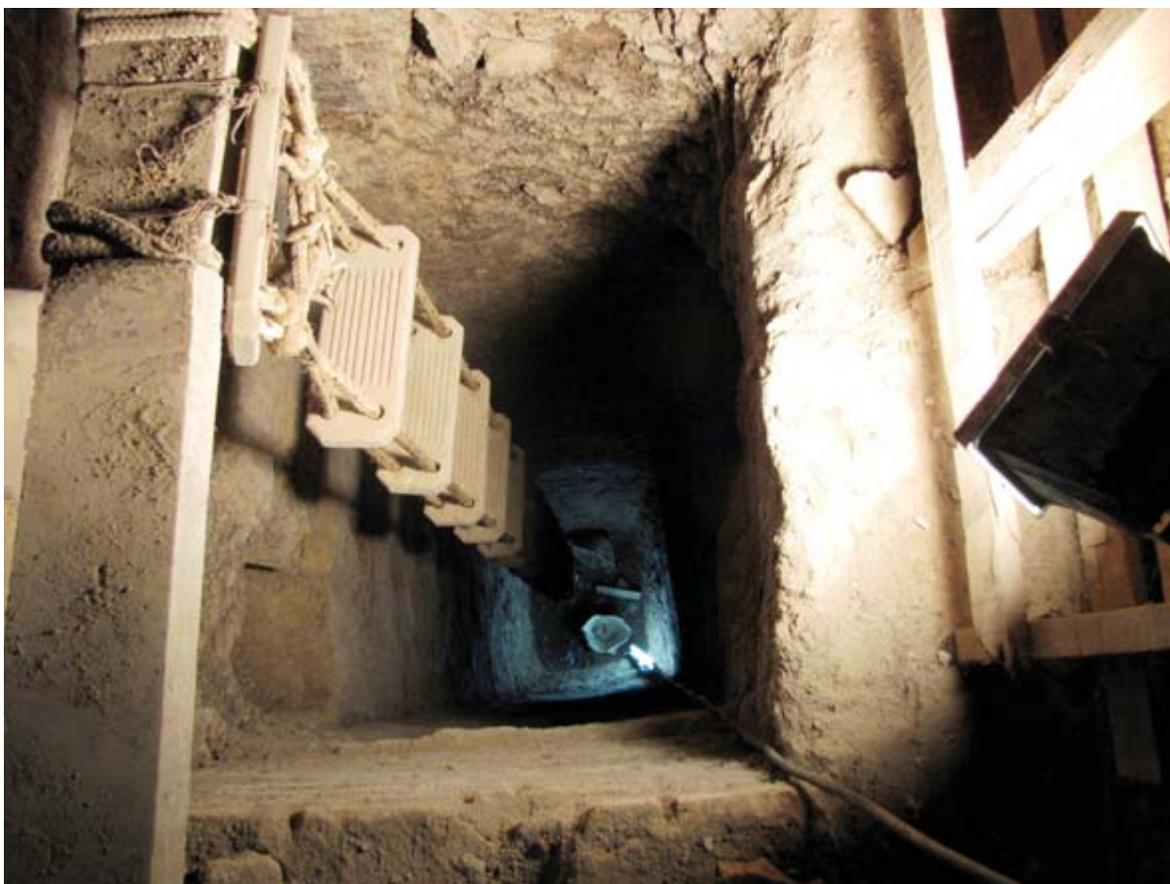
Probable pozo de absorción cavado en la tierra con parte superior de ladrillo durante su excavación en Bolívar 375 (Cortesía Flavia Zorzi).
