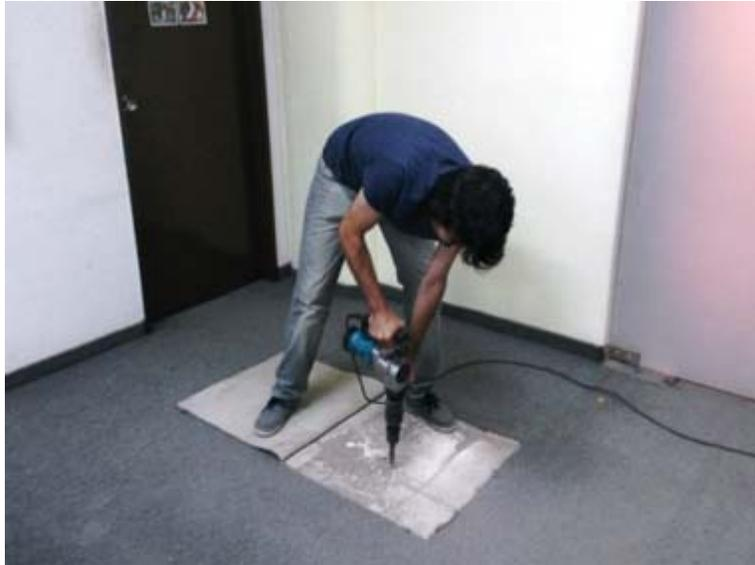
Las herramientas mecánicas de mano son necesarias para romper pisos de hormigón, y pueden usarse con cuidado (apertura de la cisterna de la casa Estrada).
