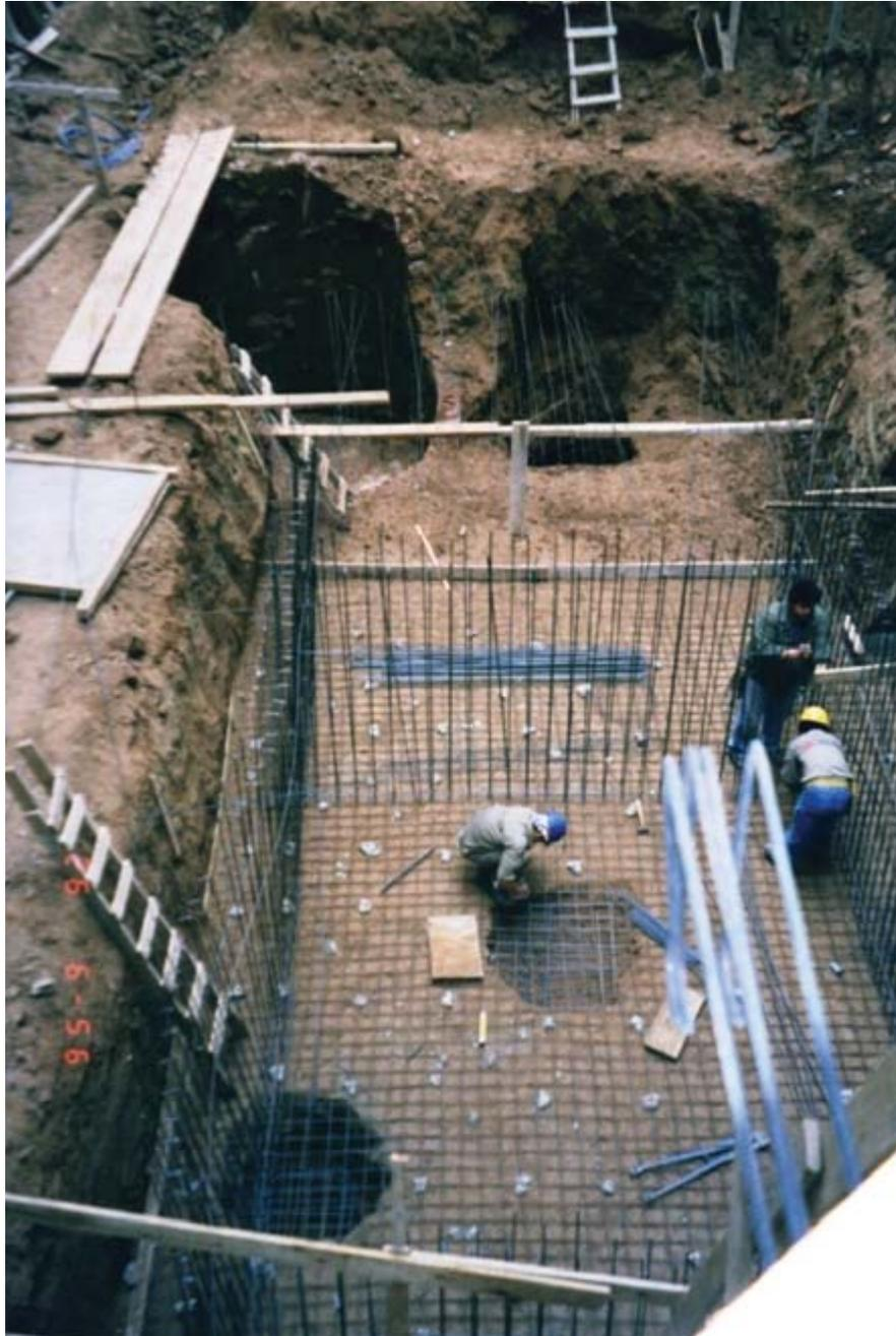
Proceso de hormigonado de una excavación: nótese los círculos oscuros de los pozos de agua bajo la parrilla de hierro y al fondo dos cisternas de diferente época (H. Yrigoyen 979). Fue excavado siguiendo el orden de la obra.
