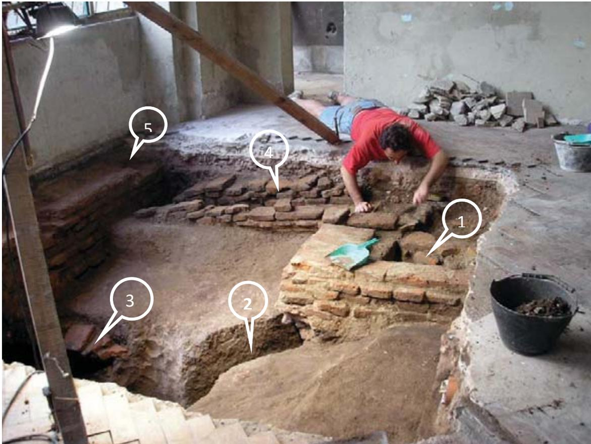
Los cambios en un baño a lo largo de dos siglos. Primera etapa: 1) sitio del asiento del inodoro, 2) conducto en la tierra, 3) pozo de descarga del baño. Segunda etapa: 4) albañal a una cisterna exterior, 5) cimiento que pasa por encima del pozo y el albañal (Bolívar 375).
