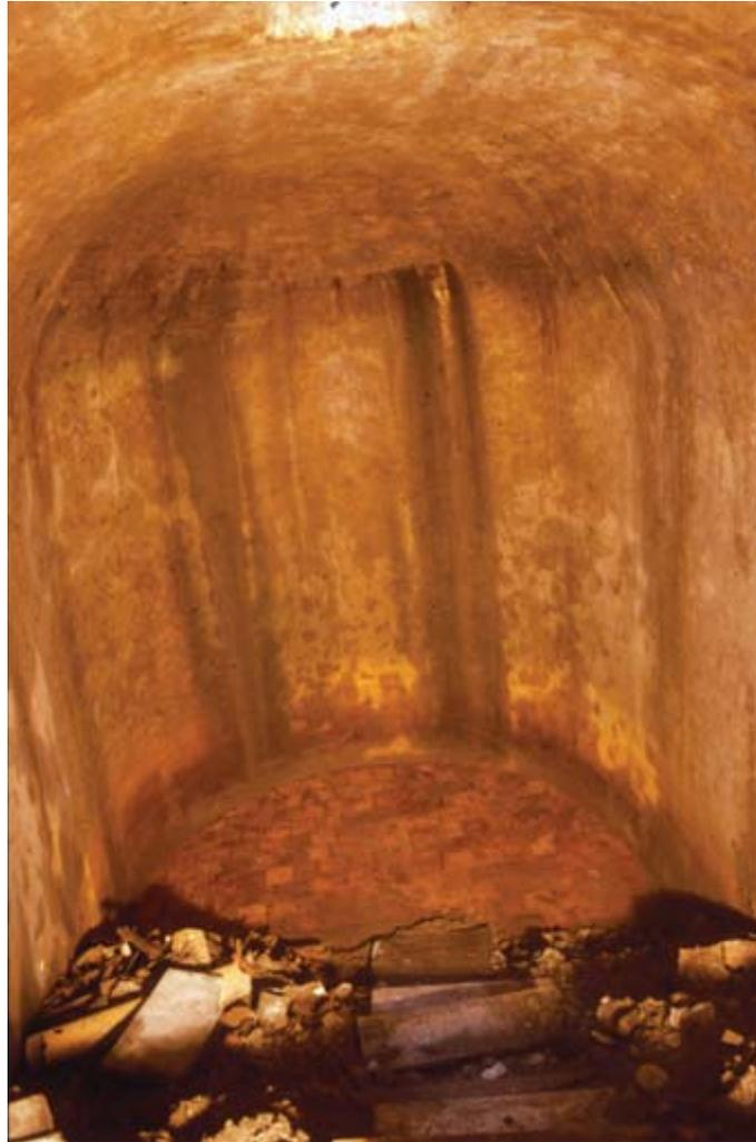
Cisterna ovalada de la Imprenta Coni destruida en 2018, mostrando sus muros de cemento y el piso de baldosas francesas en su excavación de 1990.
