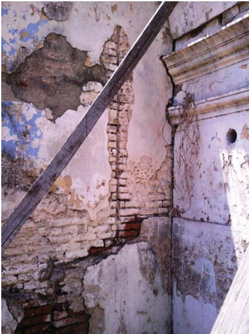
Separación por asentamientos desiguales de dos construcciones unidas de épocas diferentes; nótese las molduras de la parte de adelante que penetran en el otro muro (Museo de La Matanza).
