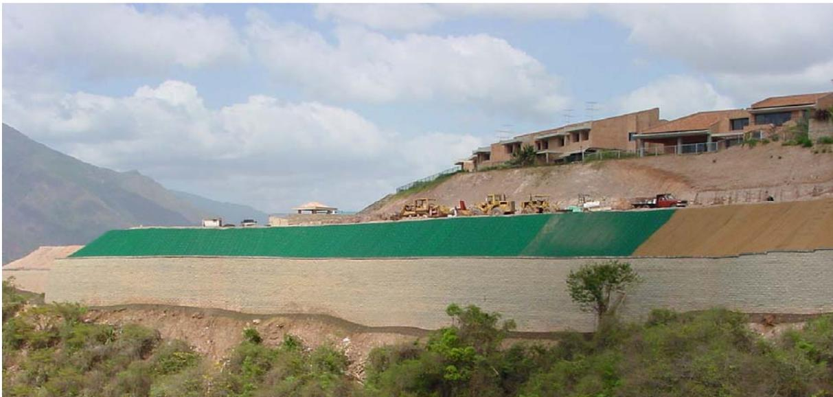
Protección de taludes y base del muro con mantos de control de erosión sintéticos y naturales
