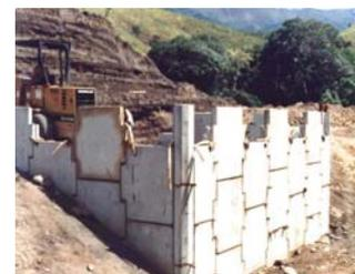
Imágenes de dos macizos de tierra armada mostrando las escamas o paneles prefabricados en concreto y los flejes de hierro dulce galvanizado con los cuales se arma el suelo ubicado detrás del paramento. (Estribos).
