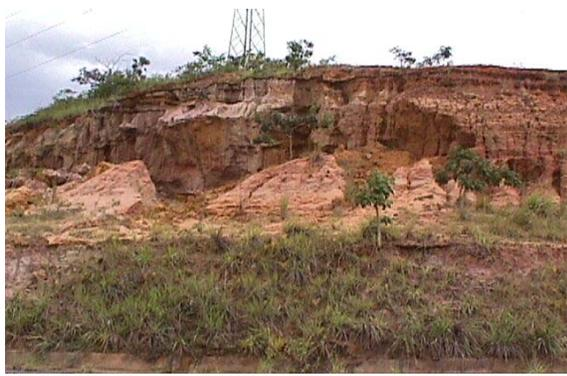
Erosión progresiva del talud debajo antena
