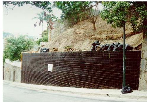
Sección Ilustrativa del macizo de tierra reforzada con paramento de malla electro soldada. En la cara o paramento, entre el suelo y la malla se coloca un geotextil no tejido de 200 grs./m<sup>2</sup> para evitar la salida del suelo o finos y evitar manchas en la fachada. Posteriormente se le coloca la vegetación para ocultar el paramento.
