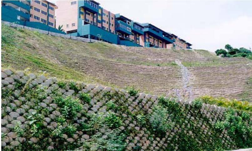
En la imagen se aprecian los bloques articulados LOEFL® con vegetación intercalada saliendo entre los mismos. Aplicación de biotécnica en el pie de un talud combinada con una solución de bioingeniería en base a fajas del talud superior.
