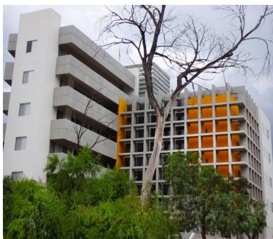
Fig.29. Edificio de la Coordinación para la Innovación y Aplicación de la Ciencia y Tecnología Foto: Lucy Nieto
