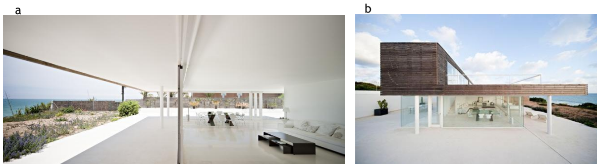
Figura 21. Vista do interior de DBJC House (a), vista do exterior de DBJC House (b)
