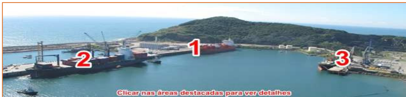
Figura 2- Berço de atracação Porto de Imbituba.
