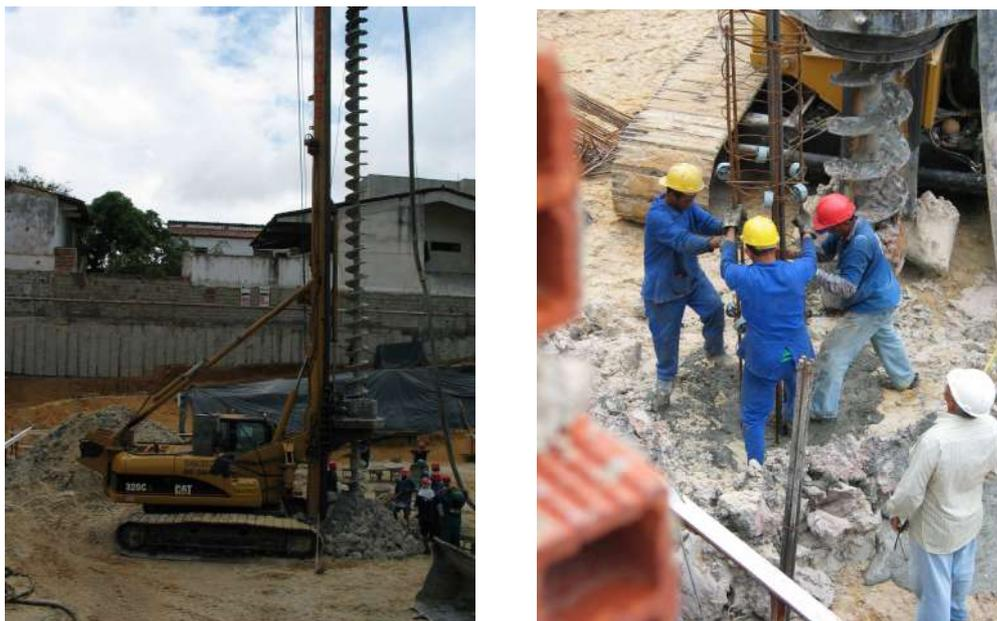
Figura 5.15 – Execução das estacas hélices contínuas
