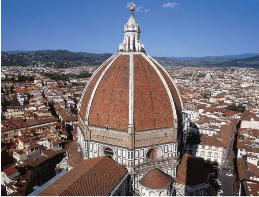
Fig. 7.7. Cúpula de Santa María de las Flores de Filippo Brunelleschi (1418). Inspirada en las cúpulas clásicas une en su construcción alardes técnicos como el contrarresto de empujes a través de la propia construcción, propios del sabio renacentista.
