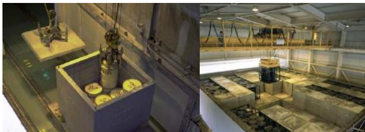
Figura 51. Llenado de unidades de almacenamiento con bidones de 220l y posterior llenado de celdas de almacenamiento en El Cabril
