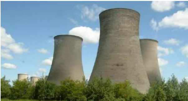
Figura 21. Torres de refrigeración
