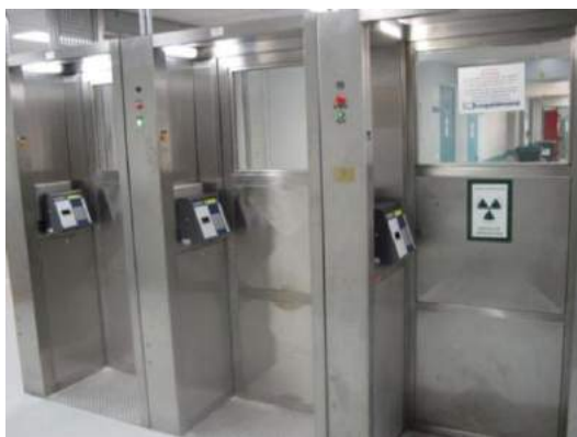
Figura 45. Acceso a zona controlada
