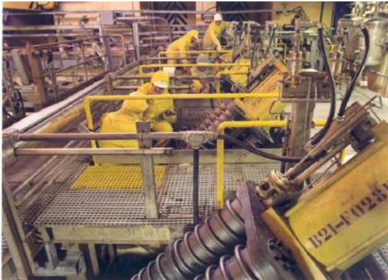
Figura 38. Válvulas de aislamiento de las líneas de vapor principal en el edificio de contención para una central BWR
