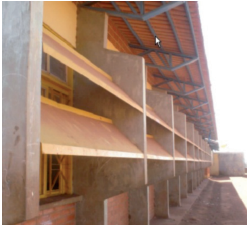
Uso de quebra-sol em escola. O telhado também auxilia na proteção à insolação.
