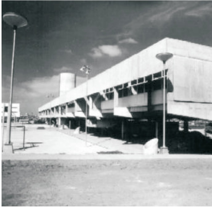
Quebra-sol de concreto.
