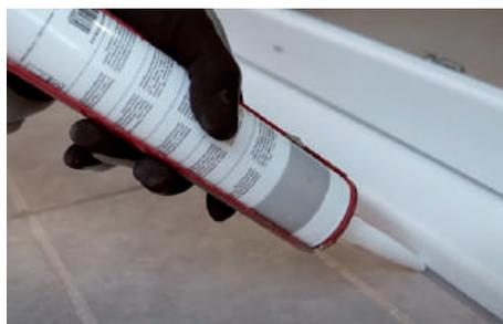
*Figura 3.13. Sellado exterior de ventana. Fuente: Incerco Ventanas. Una buena ventana necesita una buena instalación. [www.youtube.com](http://www.youtube.com)*
