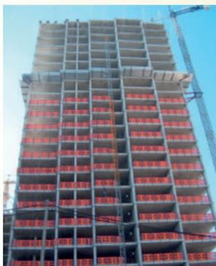
Figura 3.33. Visera de protección contra la caída de materiales colocada entre los forjados que se encuentran en fase de estructura y aquellos en los que se va a ejecutar el cerramiento de fachada. Fuente: GESPRE
