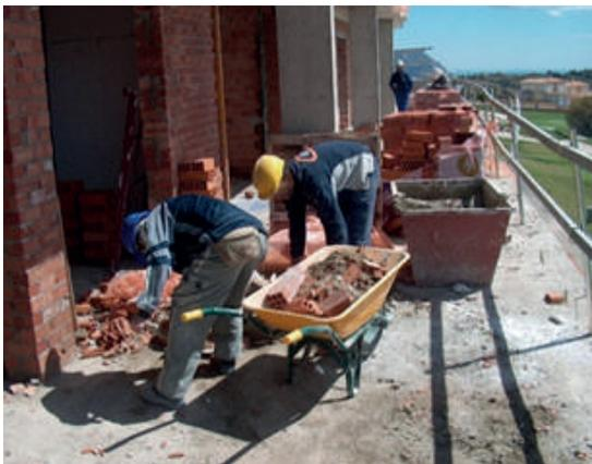
Figura 2.11. Labores de limpieza y retirada de residuos.
