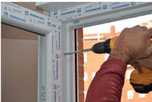
Figura 3.4. Fijación de marco a muro mediante atornillado.
