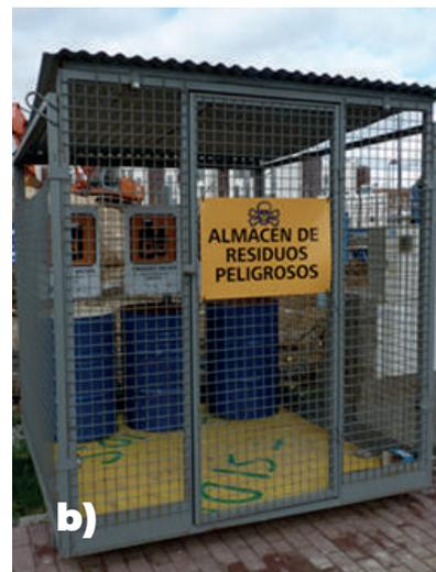
Figura 3.32. a) Contenedor de escombros (al fondo) y contenedor con compartimentos separados para plásticos y para el papel y el cartón (en primer término). b) Almacén de residuos peligrosos. Fuente: GESPRE
