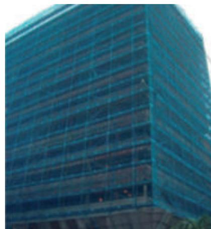
Figura 3.34. Visera mediante chapa metálica y red tipo mosquitera para proteger la vía pública frente a la caída de materiales. Fuente: GESPRE
