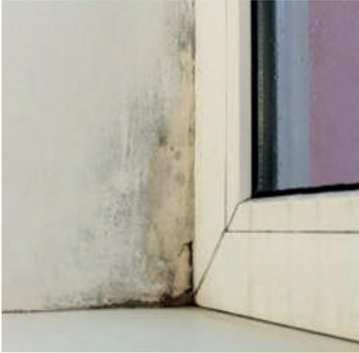
Figura 1.2. Humedades en pared por falta de estanqueidad en la unión entre el muro y la ventana.
