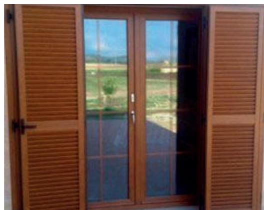
Figura 3.26. Contraventanas de lama fija
