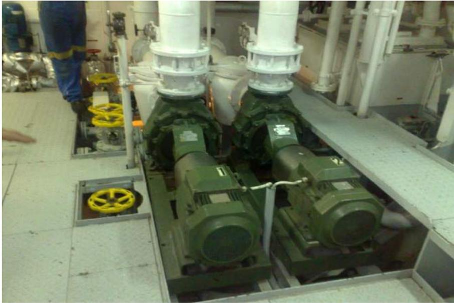
Las bombas son controladas con un sistema de válvulas hidráulicas, donde se controla la cantidad de agua que debe ser ingresada o desalojada del buque, su control se hace en cubierta. (Ver ilustración 31)
