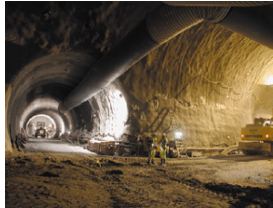
Figura 2 – Túnel de S. Gotardo (em constr.) http://www.infrastructures.com
