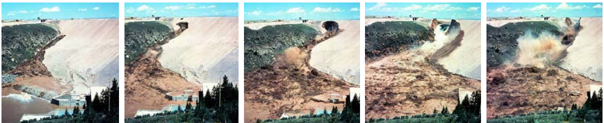
Figura 9 – Sequência de imagens da ruptura da barragem de Teton
