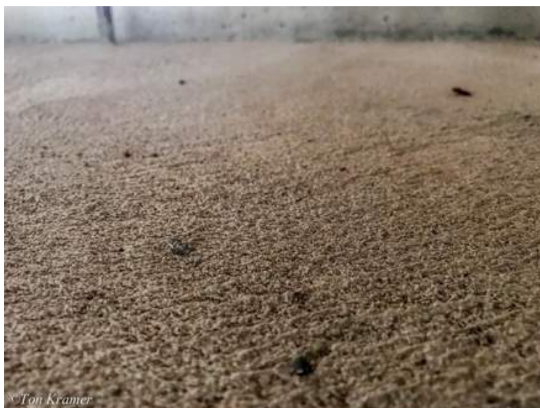
Figura 9. Projeções do concreto em piso novo, excessivamente abrasivo, responsável pelo desenvolvimento da "doença do concreto novo". ©Ton Kramer
