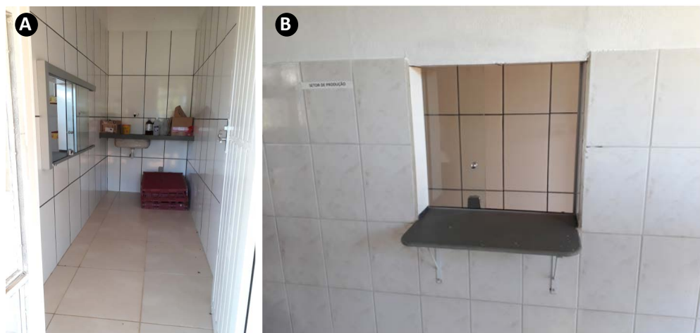
Figura 31. Detalhes da área de recepção e do depósito de melgueiras (A), com destaque para o óculo de comunicação com área limpa (B). Fonte: Arquivo pessoal – Débora C. S. de Assis.
