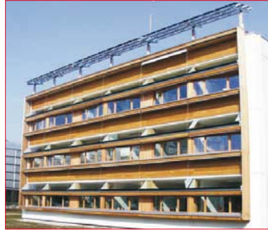
Reflectors at the Laboratoire d'Energie Solaire (LESO) in Lausanne (arch. D. Pagadaniel).
