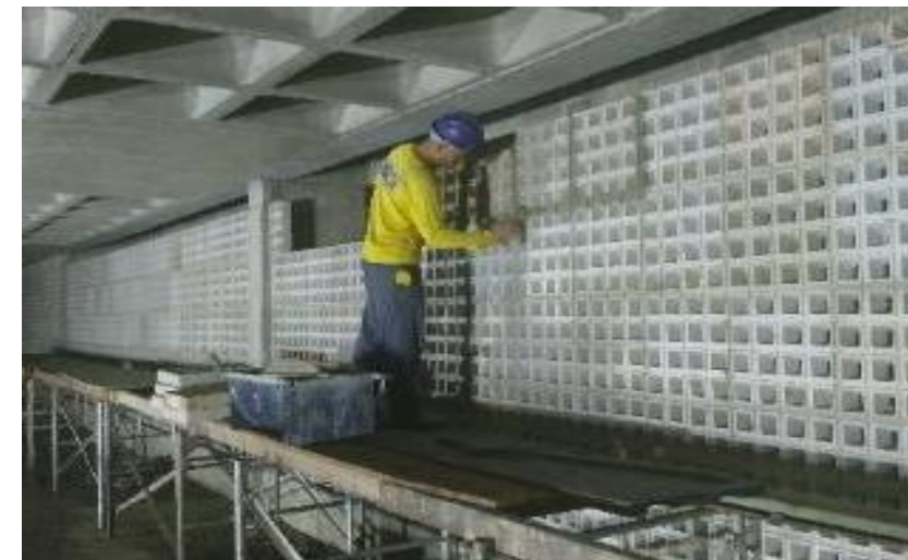
Cobogó de concreto
