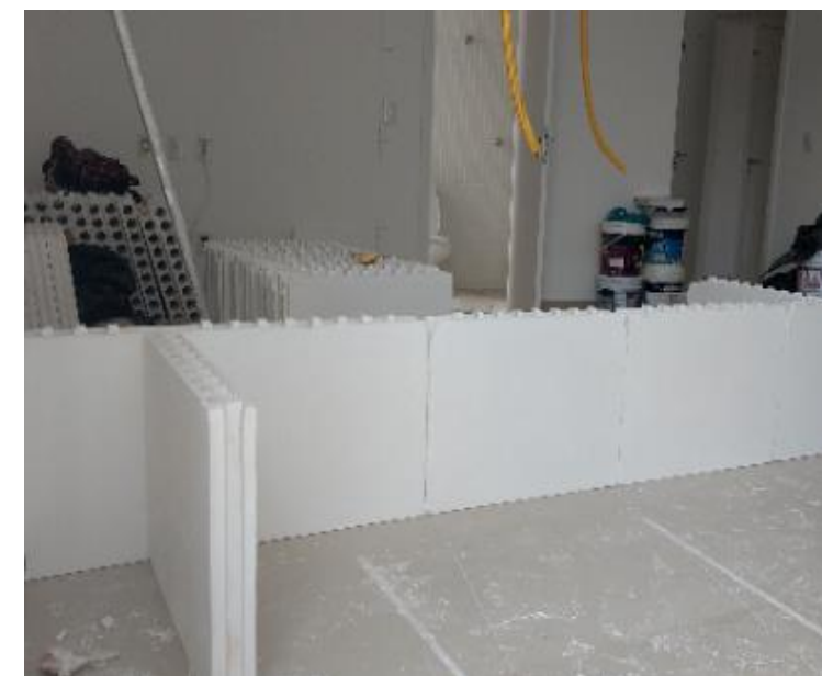
Alvenaria com bloco de gesso
