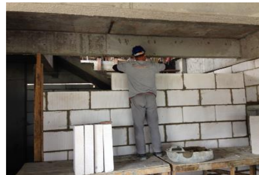
Alvenaria com bloco de concreto celular
