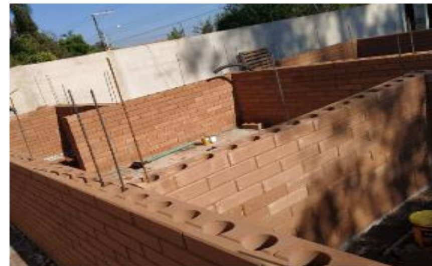
Alvenaria com Bloco Solo-Cimento
