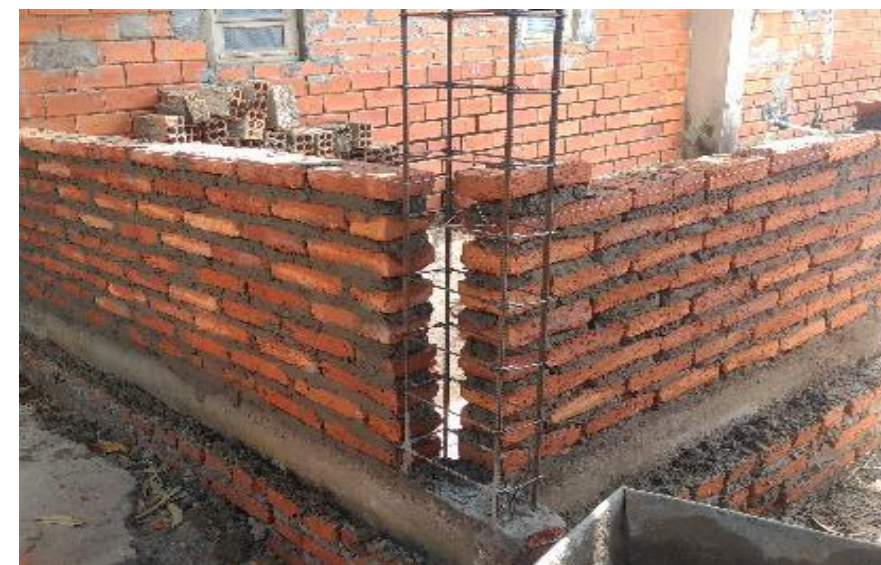
Alvenaria com tijolo maciço
