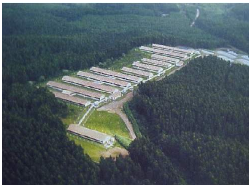
Figura 9 - Sistema de isolamento das construções utilizado para evitar entrada de doenças pelo ar Fonte: (SARTOR; SOUZA; TINOCO, 2004)
