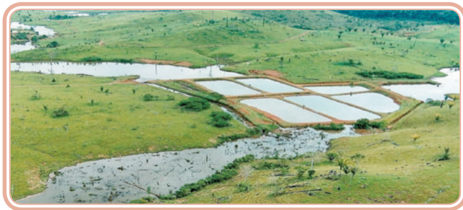
Figura 2.3: Viveiros construídos por gravidade em curso d'água
