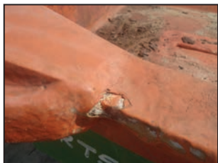
Daños leves en la regala
