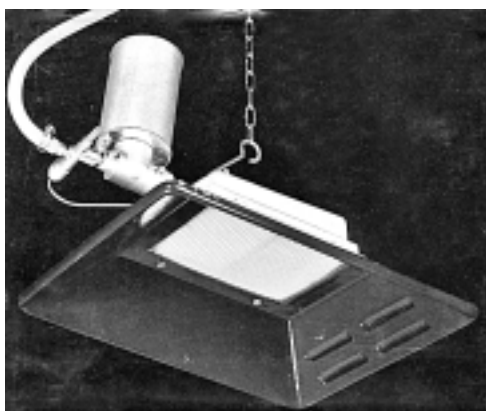
Figura 53. Criadora a gas, infrarroja.
