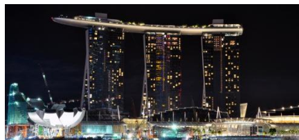
(Fig70, 71: 70 Foto izquierda Marina Bay Sands en construcción; 71 derecha Marina Bay Sands actual)
