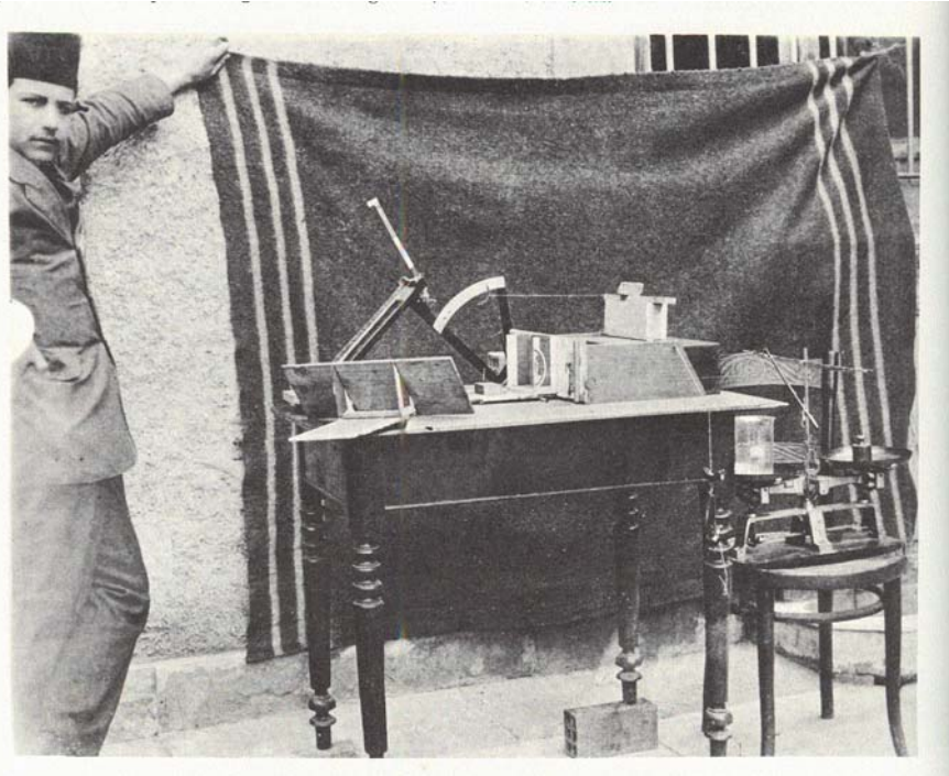
Figura 12. Aparato para estudiar empujes de tierras sobre muros en el laboratorio de Estambul
