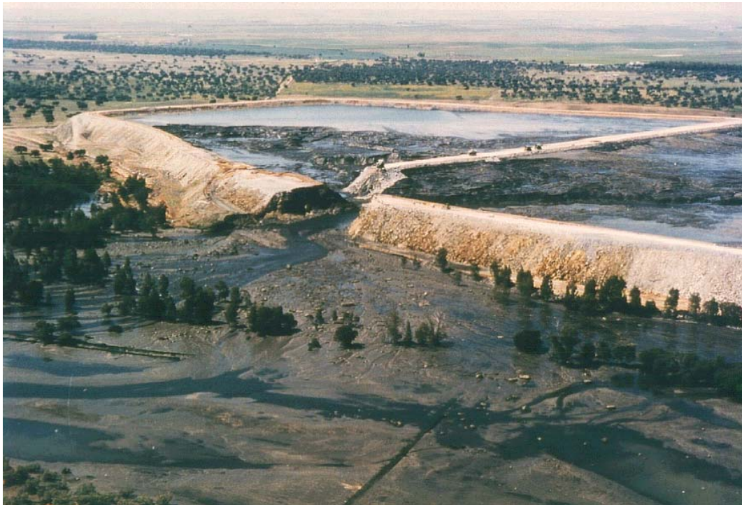
Figura 46. Rotura de la presa de Aznalcóllar el 25 de abril de 1998
