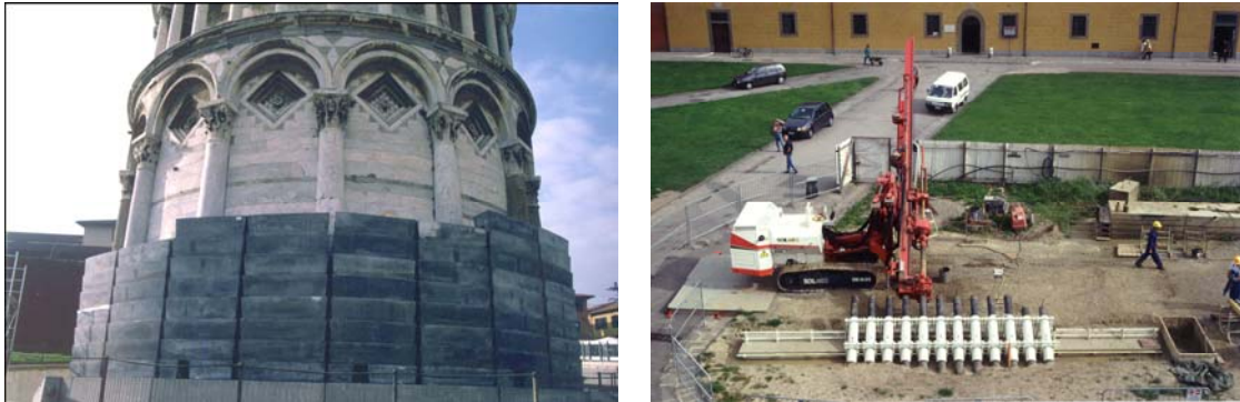
Figura 26. Aplicación de pesos en el lado norte de la torre mediante lingotes de plomo (izquierda) y sistema de extracción del terreno de la base de la torre (derecha)
