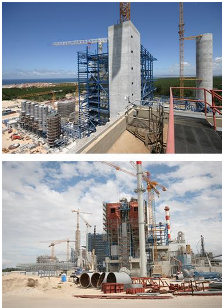
Figura 13 – Fase de construção do edifício das caldeiras.
