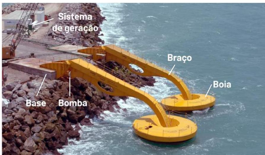
**FIGURA 9:** Foto aérea da usina de ondas do Pecém. Fonte: Estefen et al. (2010)
