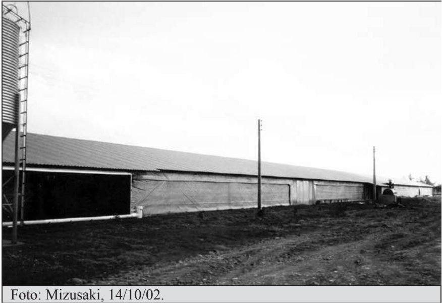
Foto 4 – Parte externa de aviário climatizado
