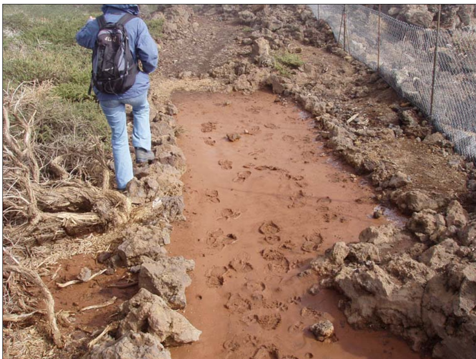
Figura 4.8: Ciertas alteraciones temporales pueden convertirse en permanentes por la ausencia de una gestión adecuada. Es el caso de los problemas de encharcamiento, los cuales pueden hacerse crónicos si no se aplica alguna de las medidas técnicas enumeradas en el Capítulo 5 de esta Tesis Doctoral. Los visitantes evitan la zona saturada de agua transitando por los bordes del trazado, lo cual incrementa la banda afectada. La imagen corresponde a la subida al Mirador de los Roques, en el Parque Nacional de la Caldera de Taburiente (La Gomera).
