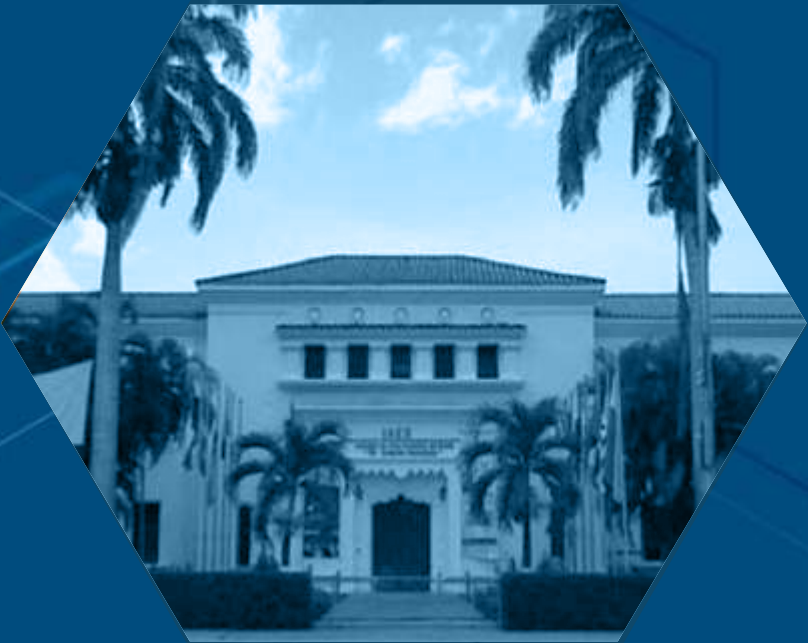
Fachada del Insituto de Altos Estudios Dr. Arnoldo Gabaldón Antigua Escuela de Malariaología y Saneamiento Ambiental. Maracay (estado Aragua)
